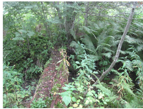
Huonokuntoinen silta uusitaan ja siirretään kauemmas pihlajasta
