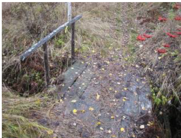
Kuva 42. Vaatimaton, mutta hyvin maastoutunut vanha silta Haapamäen havaintotilalla. Sillan pintaan on kiinnitetty verkko estämään liukkautta. (Tuula Muranen 2014)
