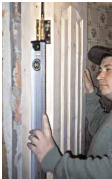
При установке вертикальность проверяют в двух плоскостях
