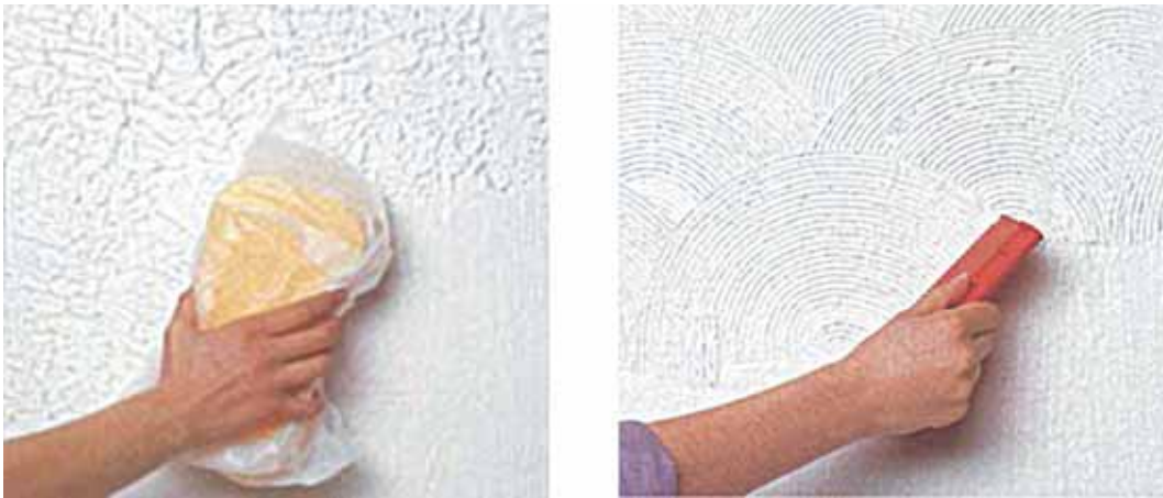
Рис. 84. Простое текстурирование окраски с помощью губки и гребня
