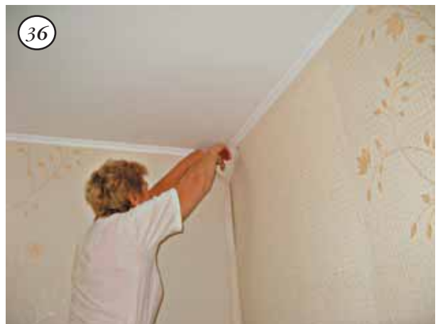
Рис. 74. Наклеивание обоев (продолжение)
