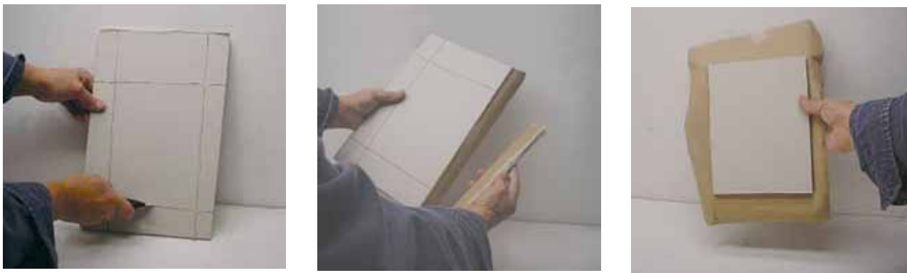
Рис. 11. Заделка небольших отверстий в гипсокартонной обшивке (начало)
