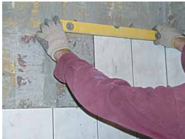
Периодически проверяем ровность укладки плитки уровнем и правилом
