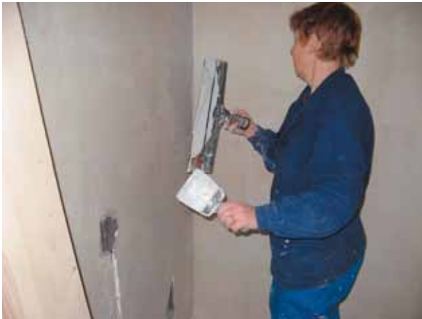
и нанести на стену, меняя шпатели по мере необходимости
