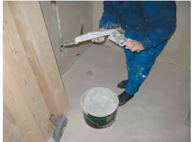
Наложить шпаклевку на шпатель
