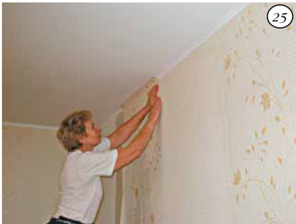
Приклеить второе полотно прокатывая его валиком и следя за стыками
