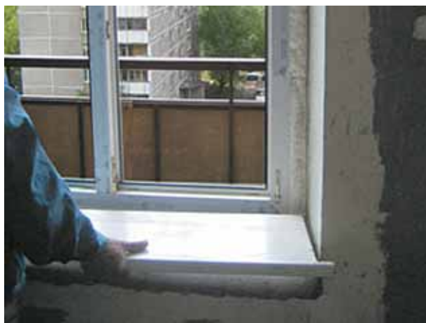
Вытлщить и установить подоконник заводя его под раму
