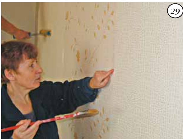
Если где-то стыки не проклеились отогнуть обои промазать клеем и приклеить вновь
