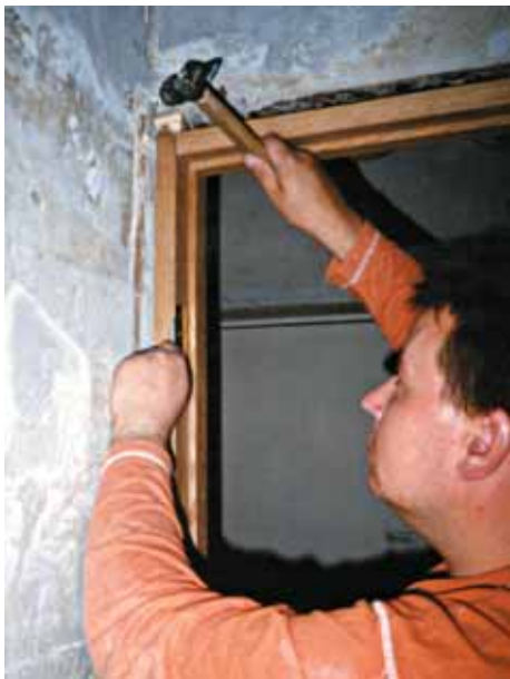
Рис. 69. Закрепление коробки клиньями
