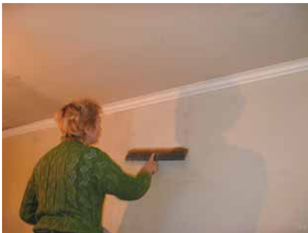
Рис. 32. Шпаклевание вторым слоем
