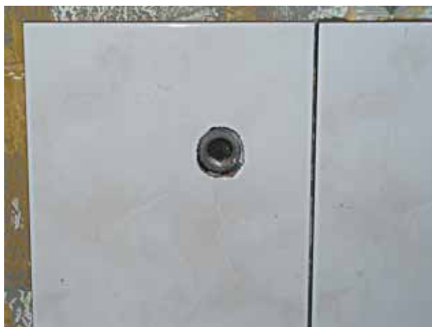
Рис. 99. Пример устройства в плитке отверстий
