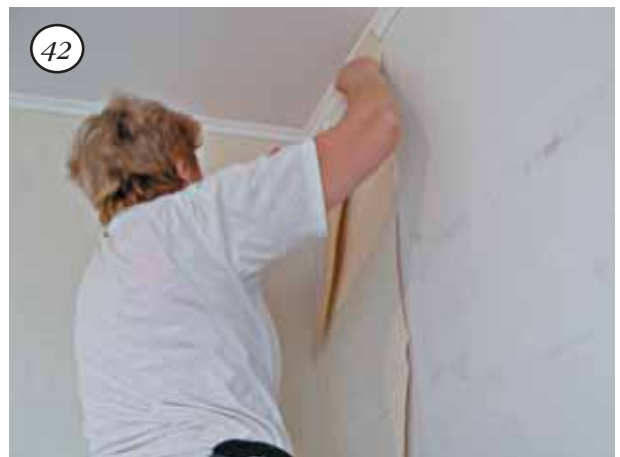
В данном случае работают опытные мастера, они могут позволить себе вклеить в угол целое полотнище и подрезать его по ширине прямо на стене. Подрезка ведется «в угол».
