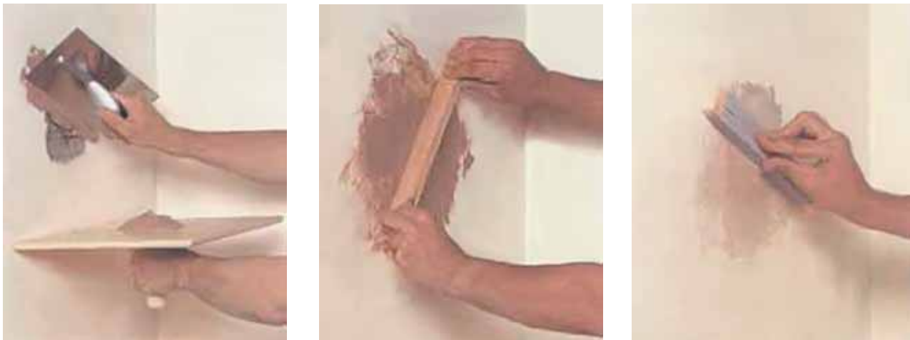
Рис.10. Ремонт поврежденных лицевого слоя гипсокартонных листов
