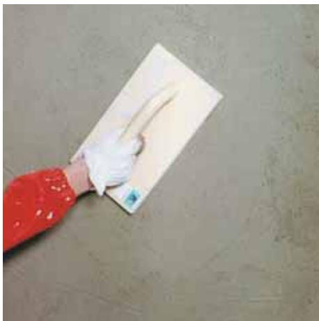
Рис. 26. Затереть штукатурку теркой
