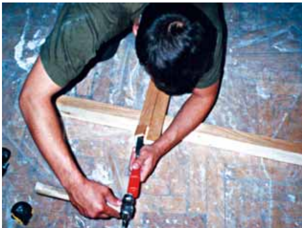
Рис. 64. Скалывание выступа притвора
