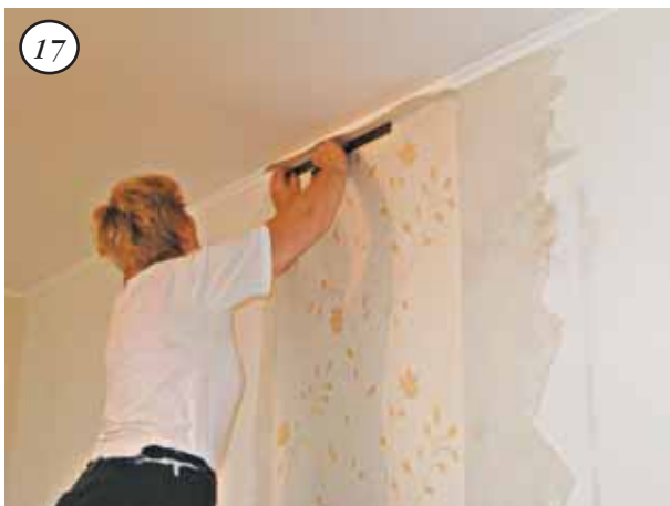
Рис. 74. Наклеивание обоев (продолжение)
