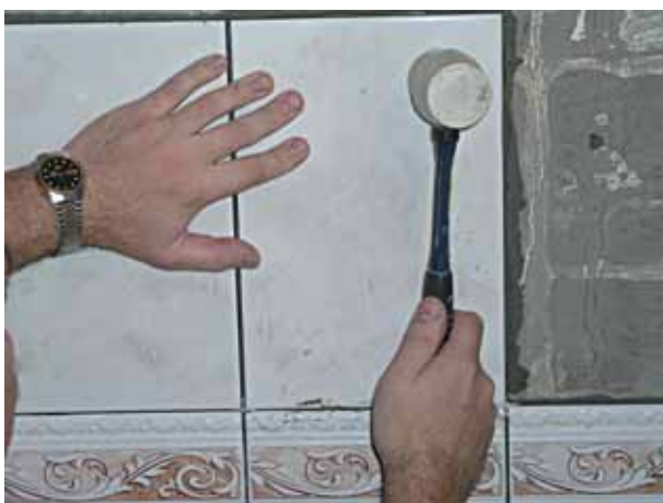
При необходимости под плитку добавляется клей или, наоборот, она осаживается легкими ударами резинового молотка
