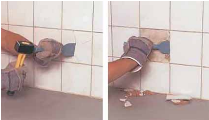
Рис. 5. Удаление облицовочной плитки
