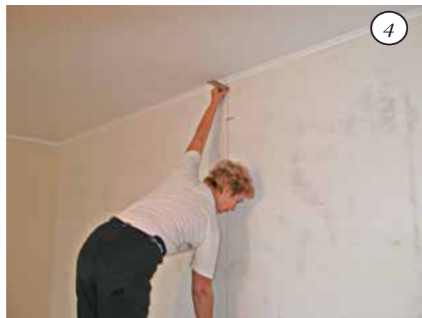
Отвесом вынести на стену вертикаль
