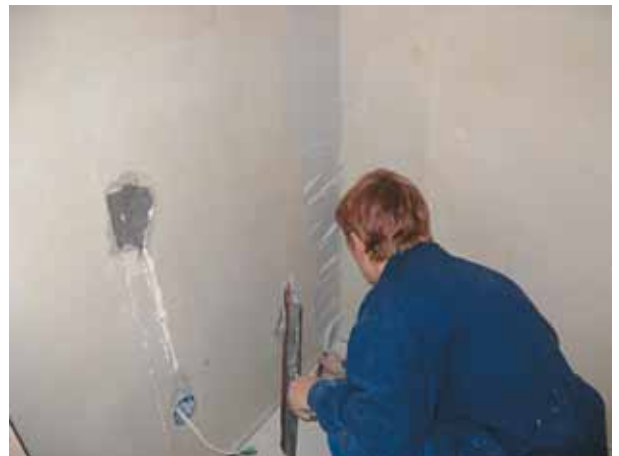
и нанести на стену, меняя шпатели по мере необходимости
