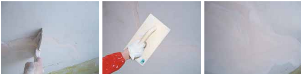
Затереть трещину теркой притирая границы
