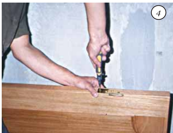
Рис. 66. Установка дверных навесок (начало)
