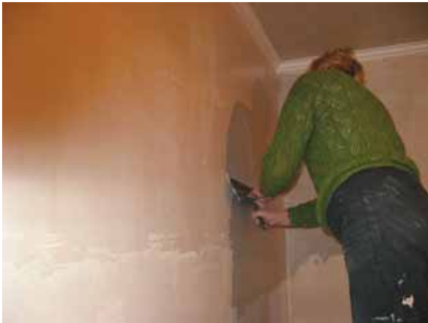
Рис. 29. Если стена не очень кривая (или вас устраивает ее ровность), то под оклейку толстыми обоями можно зашпаклевать стену только по периметру растягивая шпаклевку «в ноль» от углов стен, потолка и пола
