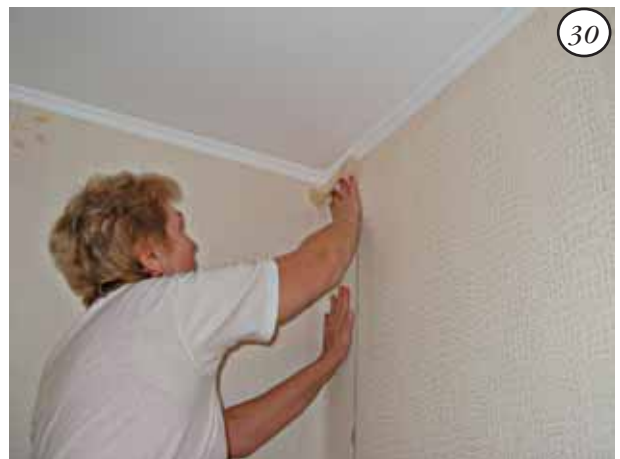
В угол вклеить полотно такой ширины, чтобы оно заворачивалось на соседнюю стену на 2–4 см
