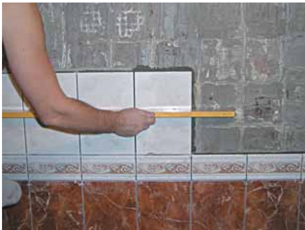
Периодически проверяем ровность укладки плитки уровнем и правилом
