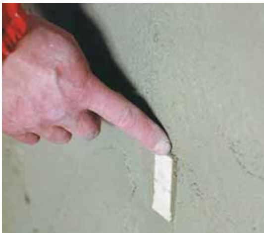
Рис. 24. Толщина первого слоя штукатурки должна быть ниже маяков (любого типа) примерно на 5 мм
