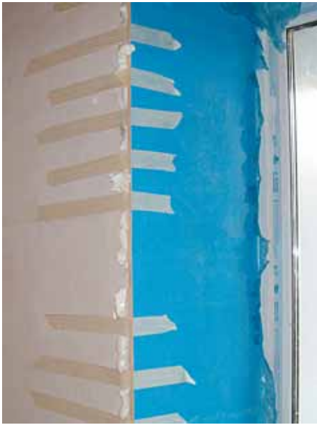
Рис. 62. Крепление второй стороны откоса бумажной клейкой лентой
