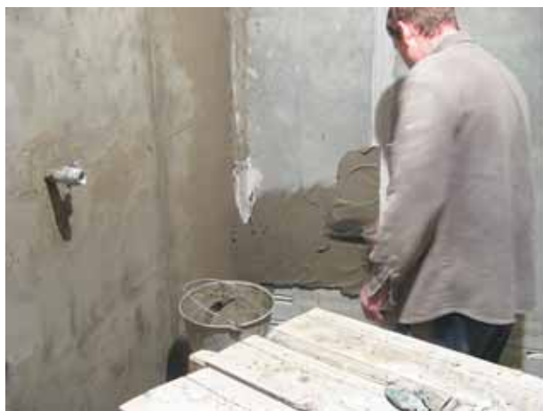
Рис. 25. Нанесение второго слоя штукатурки с выравниванием
