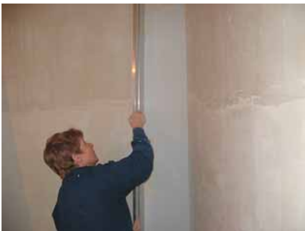
Разровнять шпаклевку правилом
