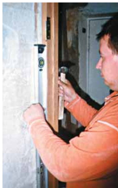
При установке вертикальность проверяют в двух плоскостях
