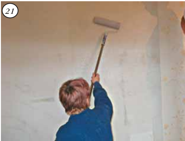
Намазать стену под следующее полотнище
