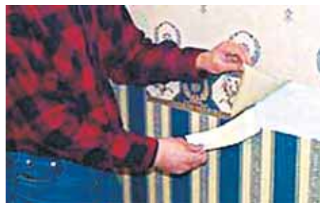
Рис. 77. Наклеивание бордюра
