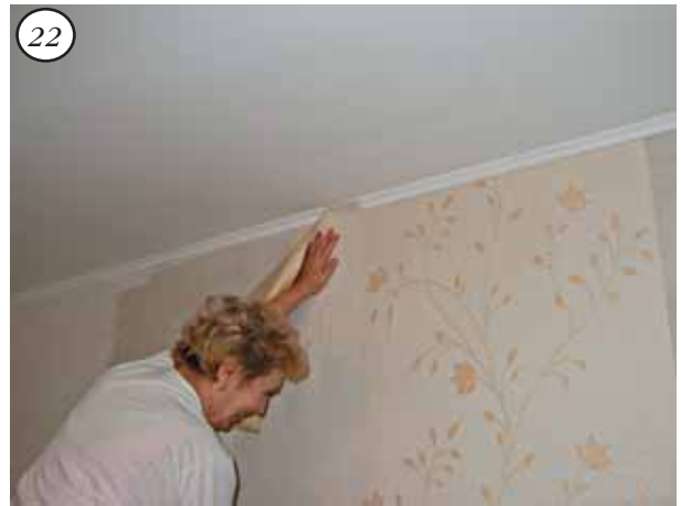
Наклеить второе полотнище рядом с первым
