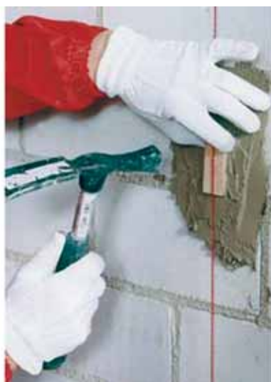
Рис. 19. Установка маяков
