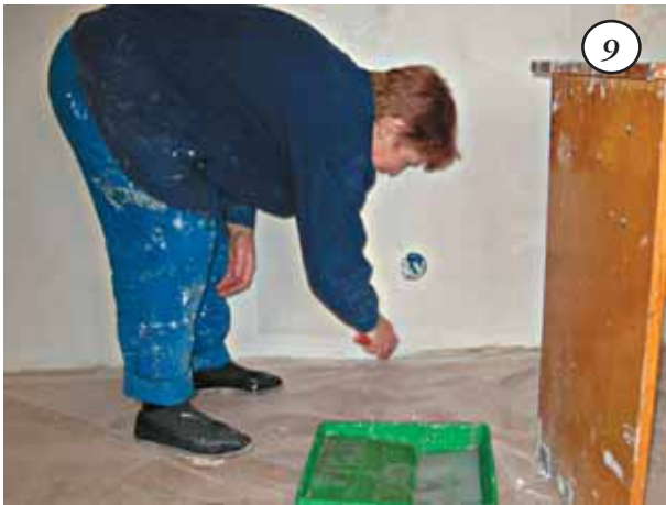
и в месте крепления плинтуса наносит клей плоской кистью (флейцем)
