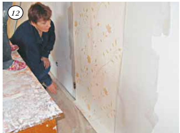
Проверить вертикальность отвесом еще раз
