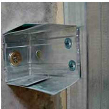
Рис. 41. Крепление каркаса обрезками профилей
