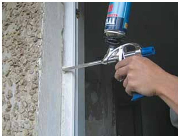
Заполнить щели со стороны улицы герметиком
