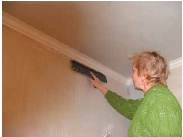
Рис. 29. Если стена не очень кривая (или вас устраивает ее ровность), то под оклейку толстыми обоями можно зашпаклевать стену только по периметру растягивая шпаклевку «в ноль» от углов стен, потолка и пола
