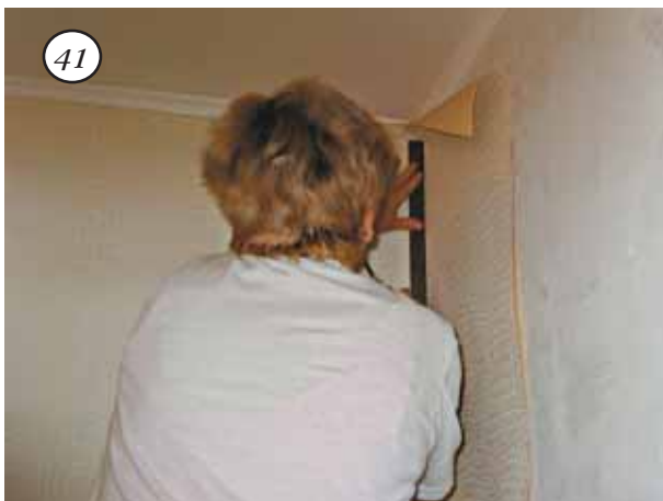
В данном случае работают опытные мастера, они могут позволить себе вклеить в угол целое полотнище и подрезать его по ширине прямо на стене. Подрезка ведется «в угол».
