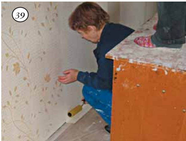
Следим, чтобы обои были приклеены по всей плоскости
