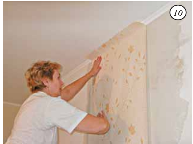
Приложить кусок обоев к стене ровняя его одним краем по черте
