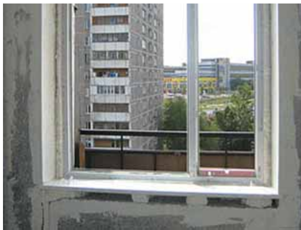
Для придания подоконнику уклона под него устанавливаются клинья
