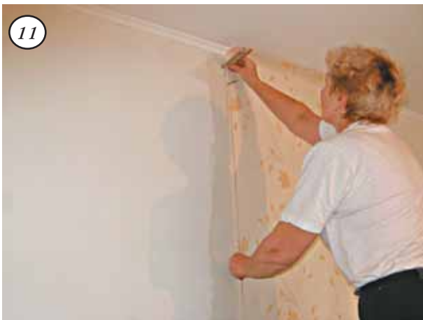
Проверить вертикальность отвесом еще раз
