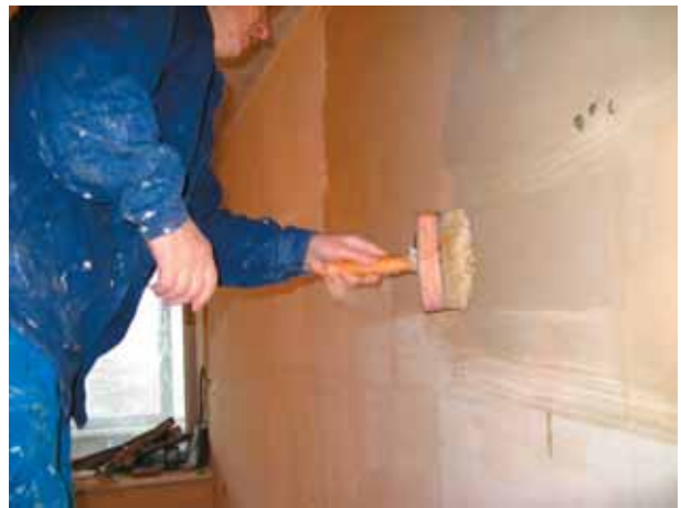
Рис. 17. Грунтование стен кистью
