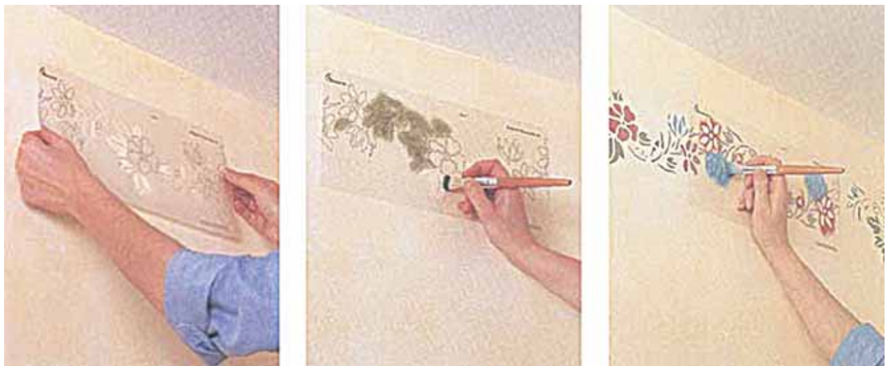
Рис. 85. Набивка рисунка по трафарету
