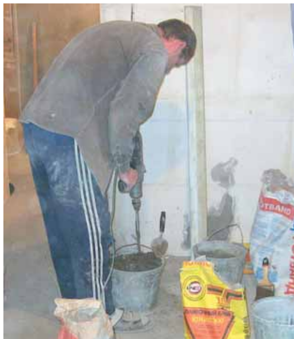
Рис. 22. Разведение сухой штукатурной смеси, в данном случае, производится выравнивание стен ванной, поэтому используется сухая смесь на цементном вяжущем
