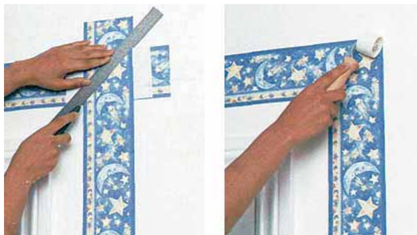
Рис. 78. Наклеивание бордюра вокруг проемов
