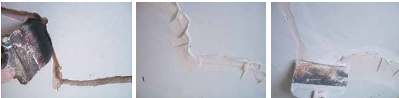
Смочить трещины грунтовкой или водой и заполнить ремонтной смесью
