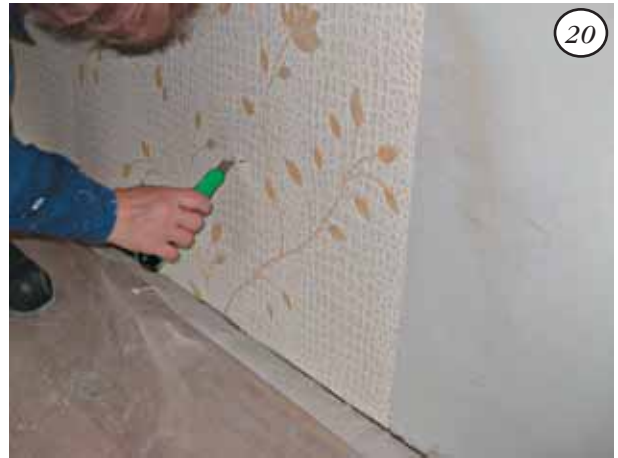
Вырезать «крест» под розетки, остальное потом подрезать ножницами
