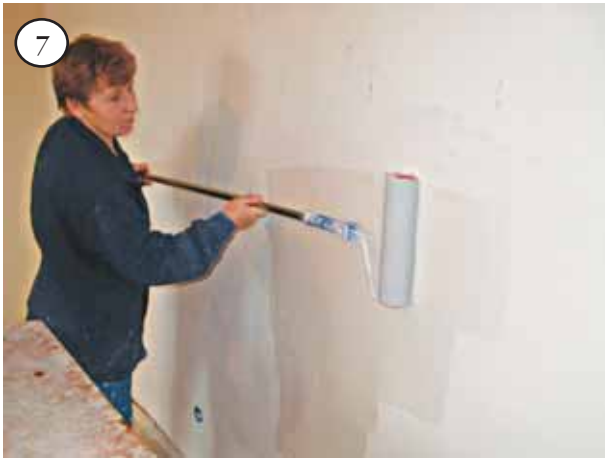
Нанести клей на стену
