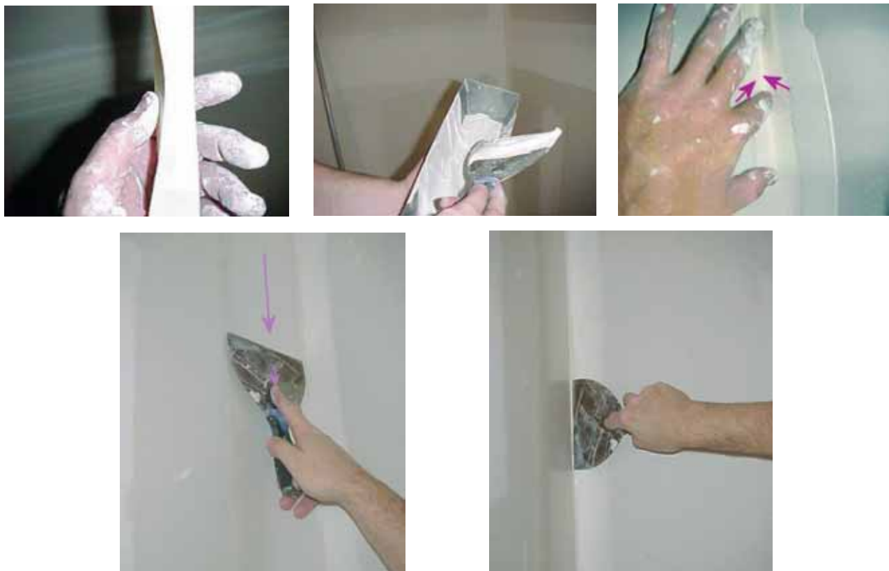
Рис. 14. Заделка трещин на внутренних углах гипсокартонной обшивки
