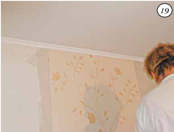
Так должны выглядеть обои после подрезки
