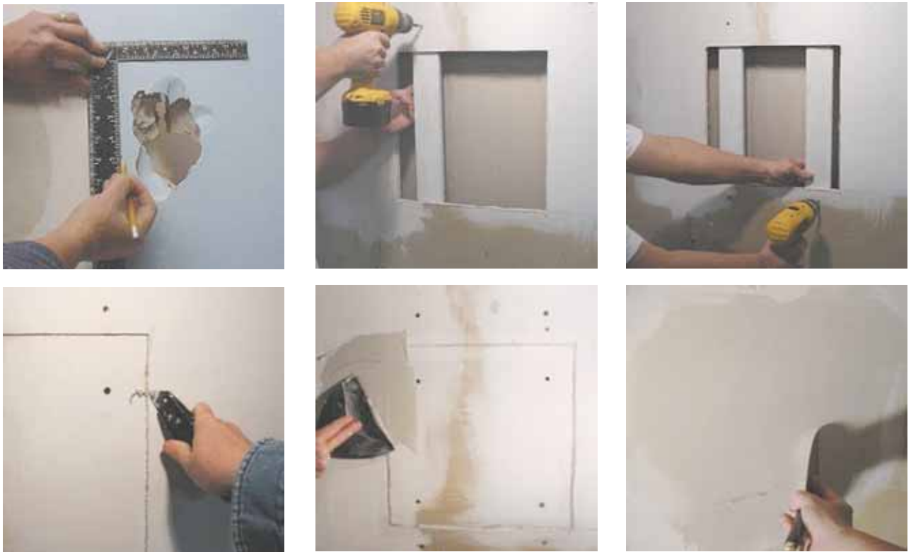
Рис. 12. Заделка больших отверстий в гипсокартонной обшивке
