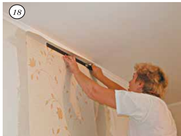
Рис. 74. Наклеивание обоев (продолжение)
