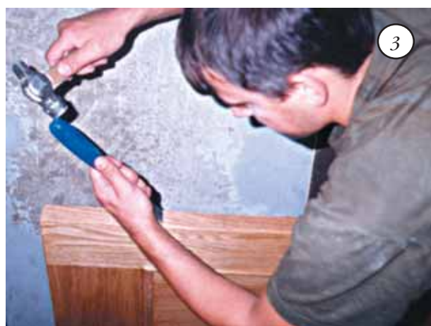
Рис. 66. Установка дверных навесок (начало)
