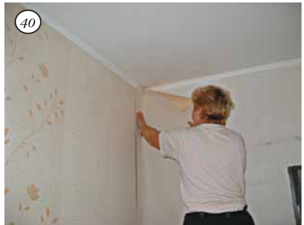
Доходим поклейкой до угла. В угол вставляем полотно с нахлестом на соседнюю стену 2–4 см
