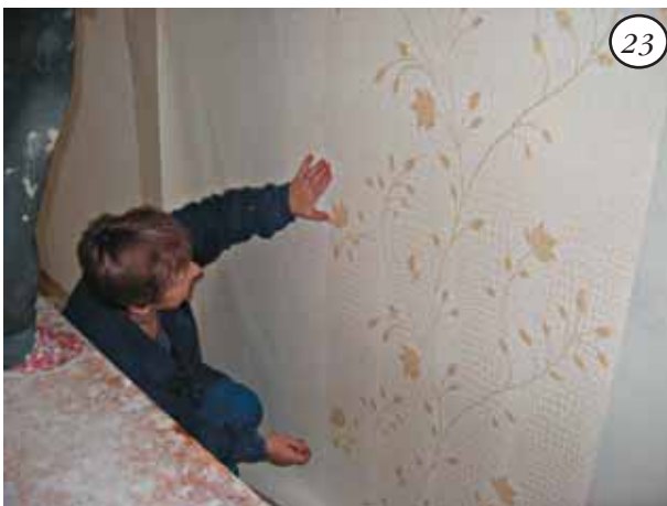
придвигая его вплотную и ровняя стык
