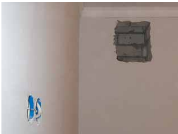
Рис. 30. При шпаклевании розетки и другие «препятствия» нужно просто обойти
