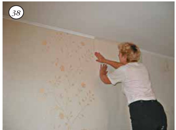
Переходим к оклейке обоев в другую сторону от центра стены
