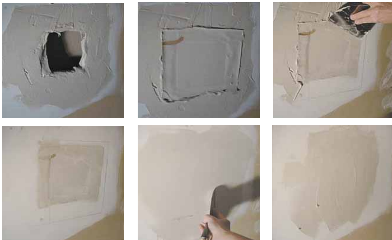
Рис. 11. Заделка небольших отверстий в гипсокартонной обшивке (окончание)
