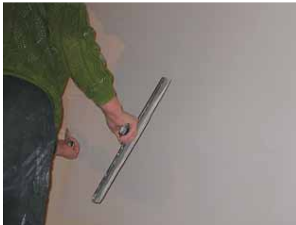
Рис. 31. Подшпаклевывание раковин и провалов
