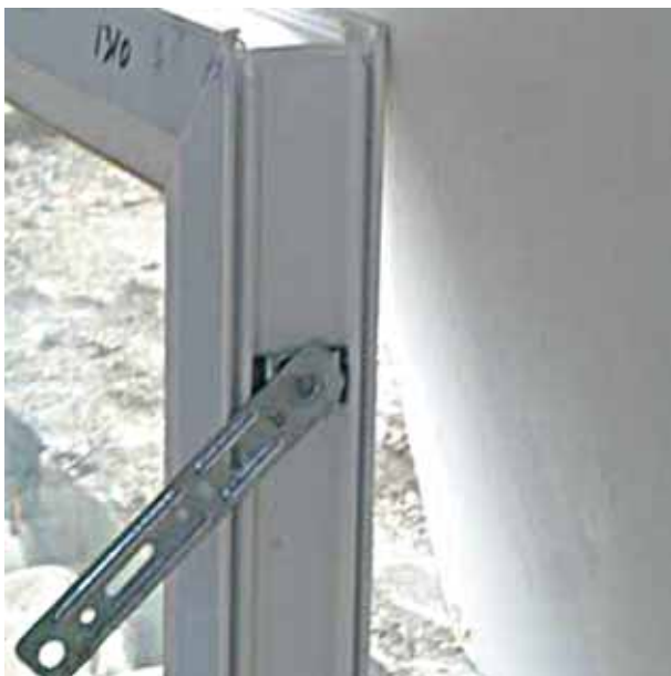
Прикрутить к раме монтажную пластину
