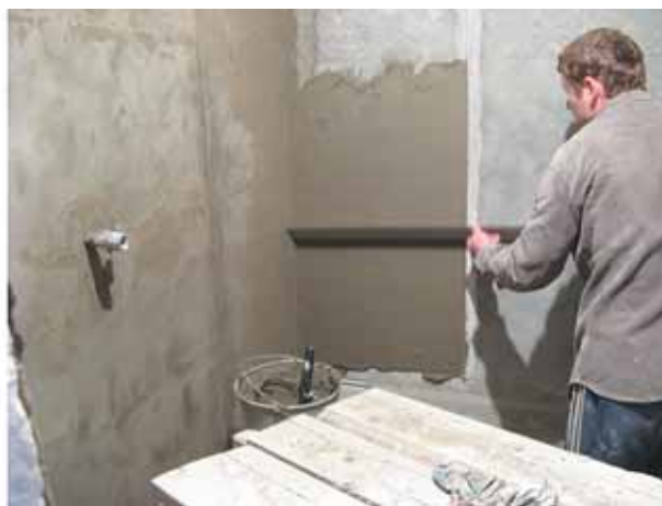
Рис. 25. Нанесение второго слоя штукатурки с выравниванием
