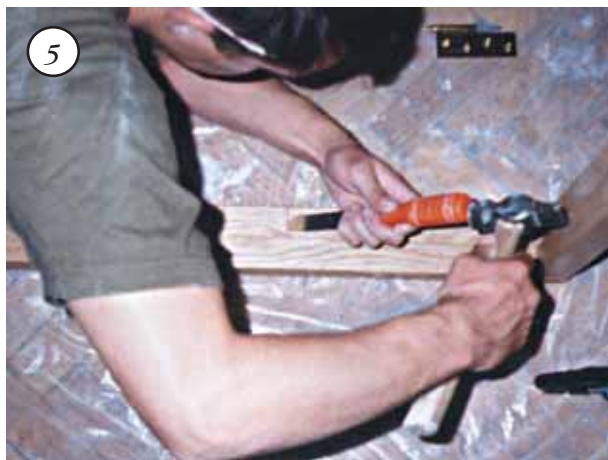
Рис. 66. Установка дверных навесок (окончание)
