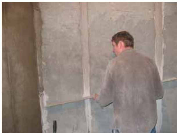
Рис. 21. Проверка толщины штукатурного намета по «вмороженным» маякам
