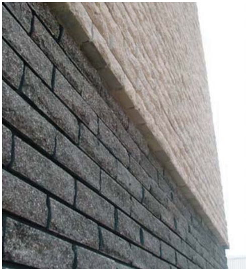
Рис. 49. Цветная кладка цоколя фактурным кирпичом
