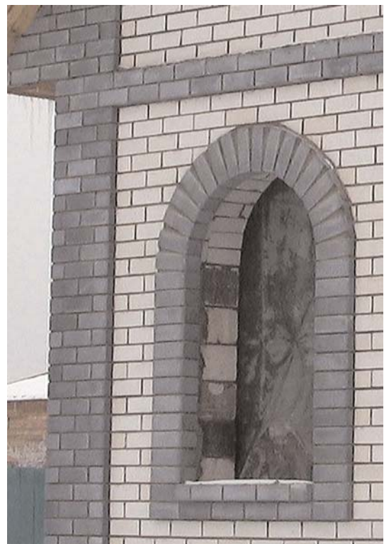
Рис. 52. Выделение лицевым кирпичом рельефных частей кладки
