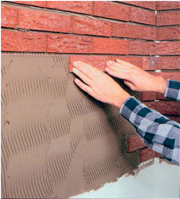
Рис. 83. Укладка рядового клинкера
