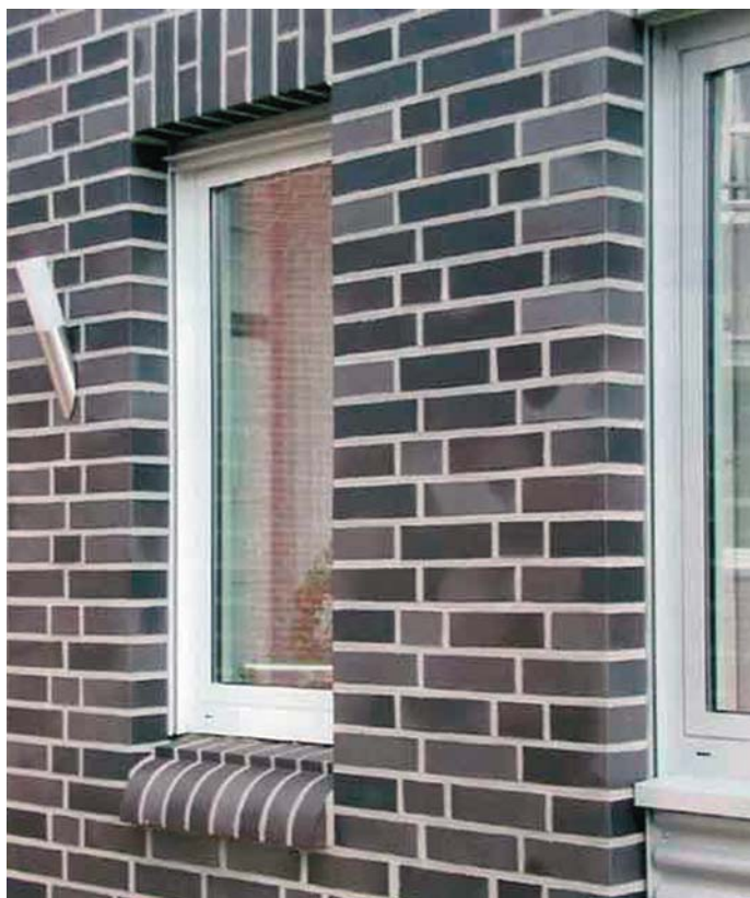
Рис. 42. Облицовка фасада кирпичом
