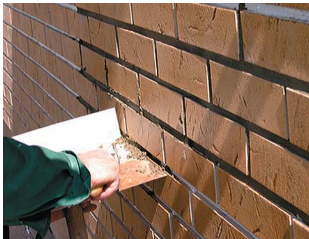
Рис. 110. Затирка швов
