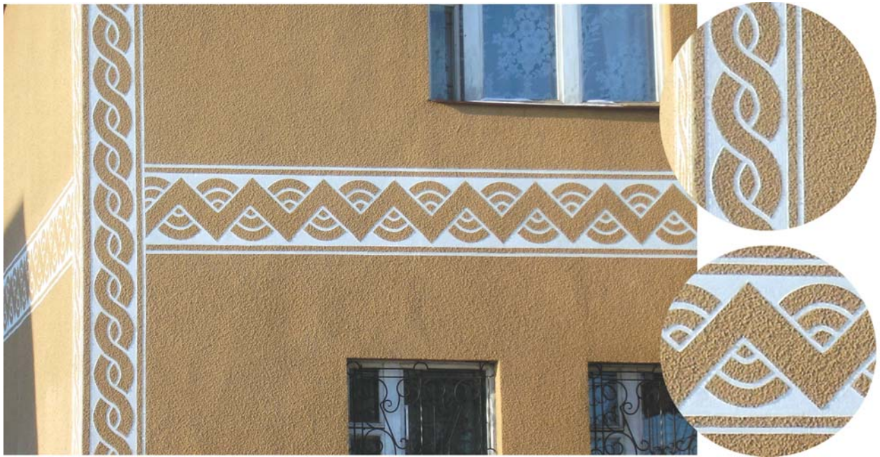
Рис. 41. Окраска фасадов по трафарету
