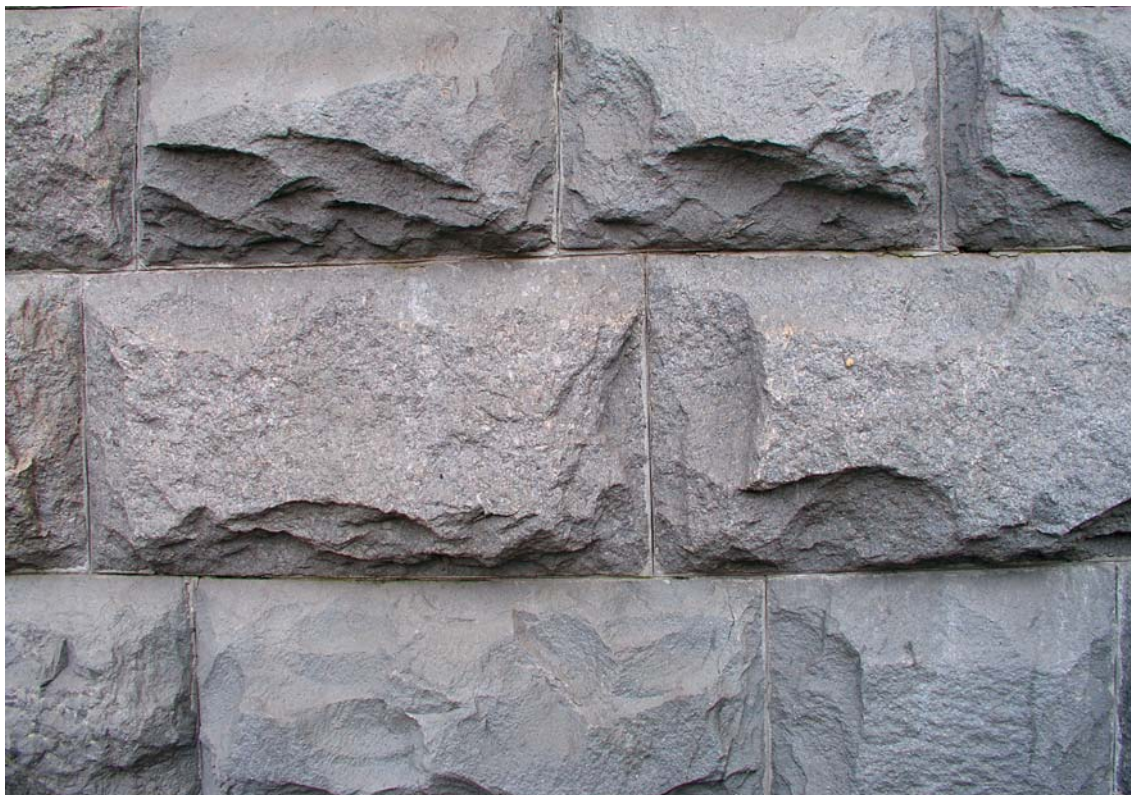
Рис. 27. Пример отделки каменной штукатурки методом наковки
