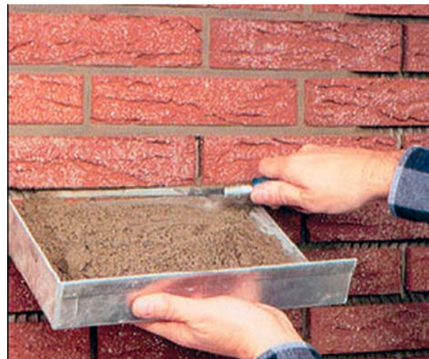
Рис. 84. Заполнение швов затирачным раствором
