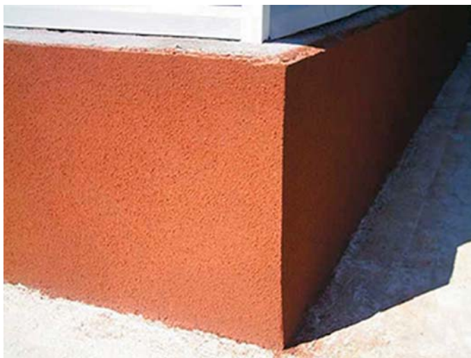
Рис. 33. Пример окраски цоколя фактурной краской
