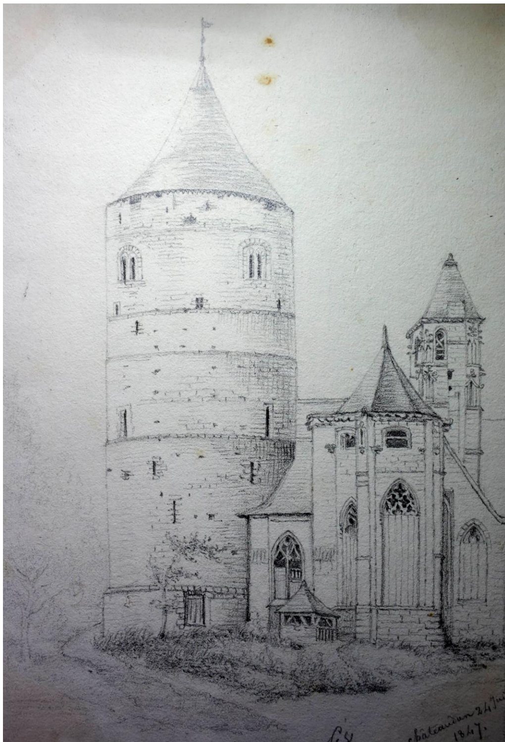
Vue du château de Châteaudun, L.V. Dessin au crayon de 1847. [Fonds patrimonial Médiathèque de Châteaudun]
