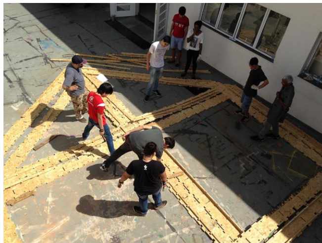
Imagem 7 – Montagem do pórtico em escala real
