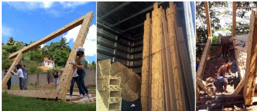
Figura 3. Pré-montagem dos pórticos, transporte em caminhão baú e início das montagens do local. Fonte: Autores, 2020.
