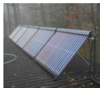
Vakuumsolfanger THERMASOL fra Huhnseal
