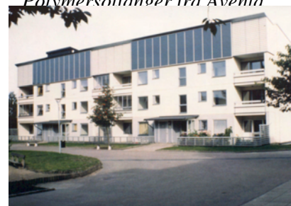
Boligkompleks ved Göteborg levert av SunLab/ABB
