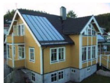
Solfanger fra Solarnor integrert i taket i et bolighus
