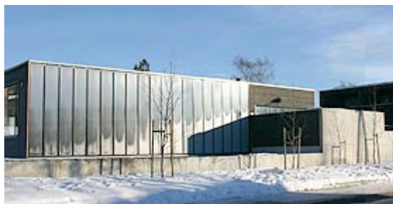
Figur 6-3 Solfangere i Bjørnveien 119 i Oslo.
