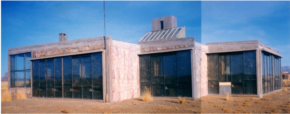
F6.-Casa solar del INTA en Abra Pampa, Jujuy a 3500 msnm. Se ven los muros Trombe frontales y el lateral así como el invernadero.
