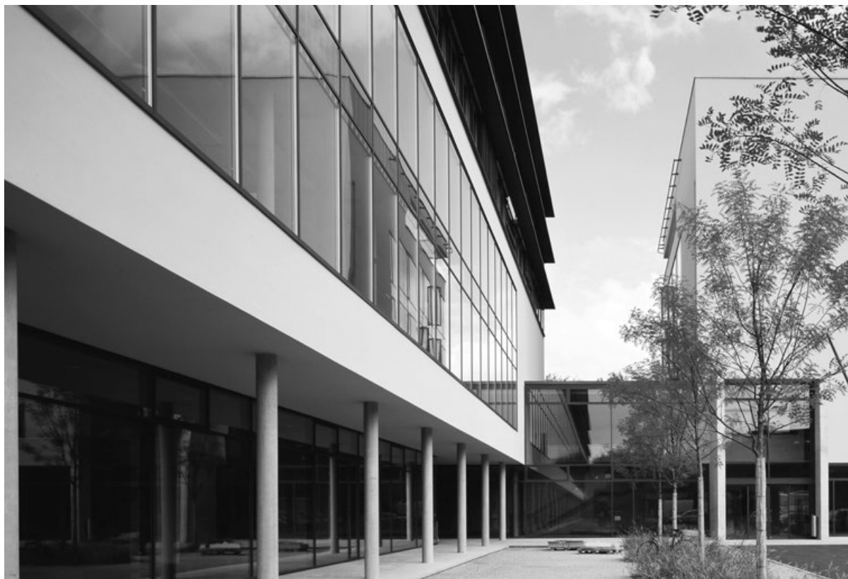
Das Fakultätsgebäude, links im Bild, mit seiner zum Verweilen einladenden Arkade, ist mit dem Gebäude mit Hauptauditorium und Bibliothek, rechts im Bild, das den stirnseitigen räumlichen Abschluss des langen öffentlichen Platzes bildet, auf mehreren Geschossen innenräumlich verbunden.
