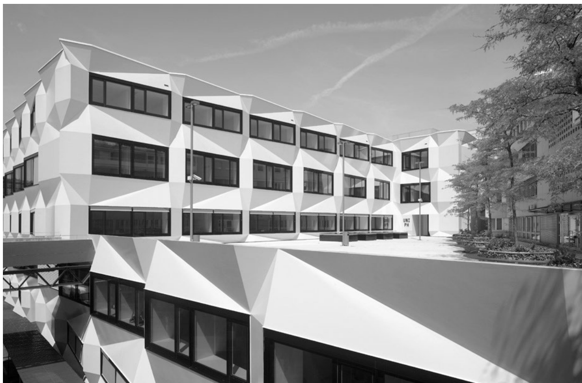
Abb. 1: Aussenansicht des Gebäudes.
