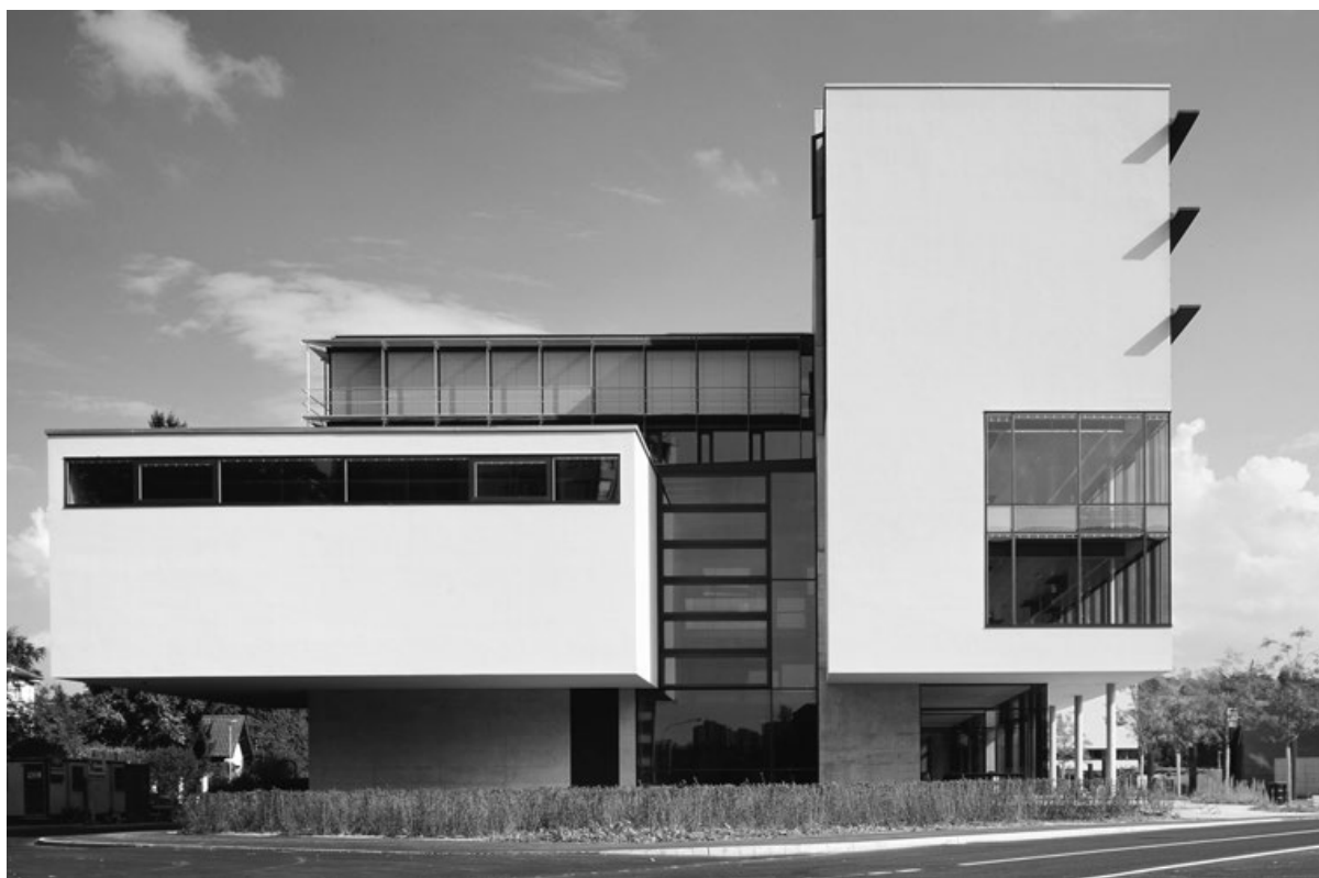
Eine klare, direkte Formensprache prägt die neuen Universitätsbauten von Pérolles II. Die Stirnfassade am Boulevard de Pérolles zeigt mit ihren geschlossenen und offenen Flächen die horizontale und vertikale Schichtung der Nutzungen in eigenständig ablesbaren Zonen.
