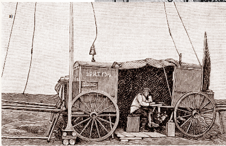
Общий вид стационарной искровой радиостанции Русского общества беспроволочных телеграфов и телефонов (РОБТнТ) и ее передвижной вариант, применявшиеся в Российской армии
