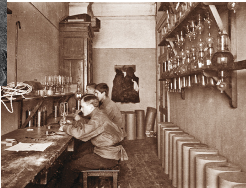
Сборка радиоламп мощностью 1,5 квт с охлаждением проточной водой. На переднем плане Д.Е. Маляров. 1920 год
