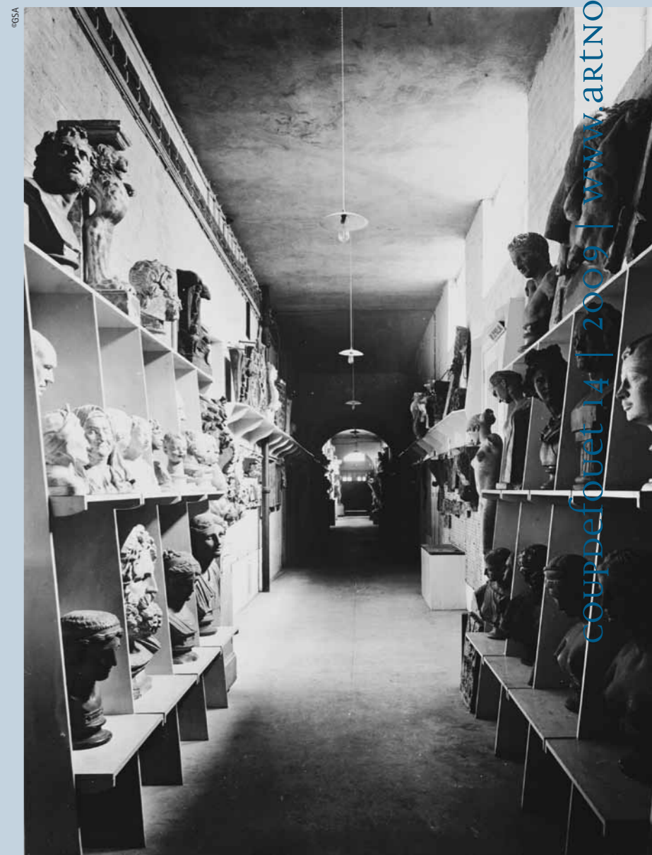
Basement west corridor. Picture taken by Bedford Lemere in 1910 Passadís oest del soterrani. Fotografia realitzada per Bedford Lemere el 1910
