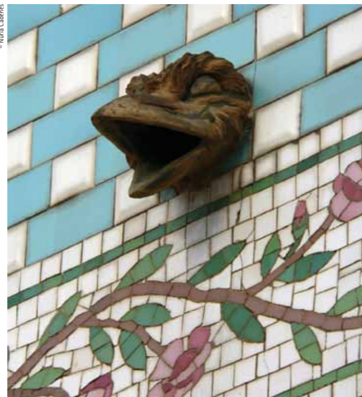
Decorative gargoyle on building at Carrer del Progrés, 262 Gàrgola decorativa ubicada en l'edifici del número 262 de carrer del Progrés
