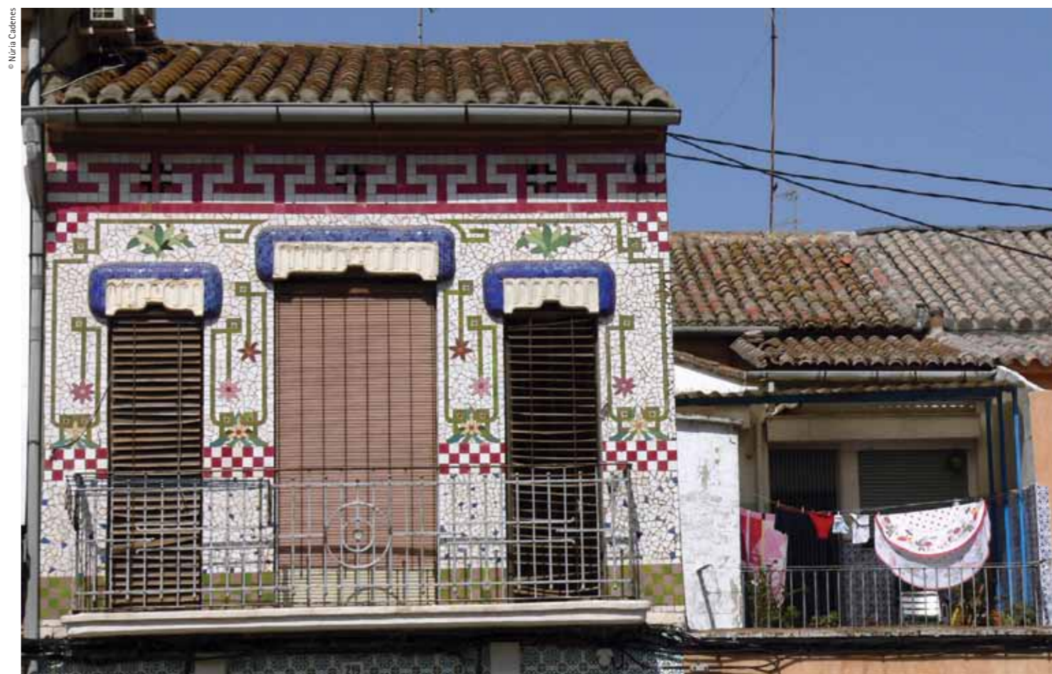
Balconies at Carrer de la Reina, 214 / Balcons al carrer de la Reina, 214
