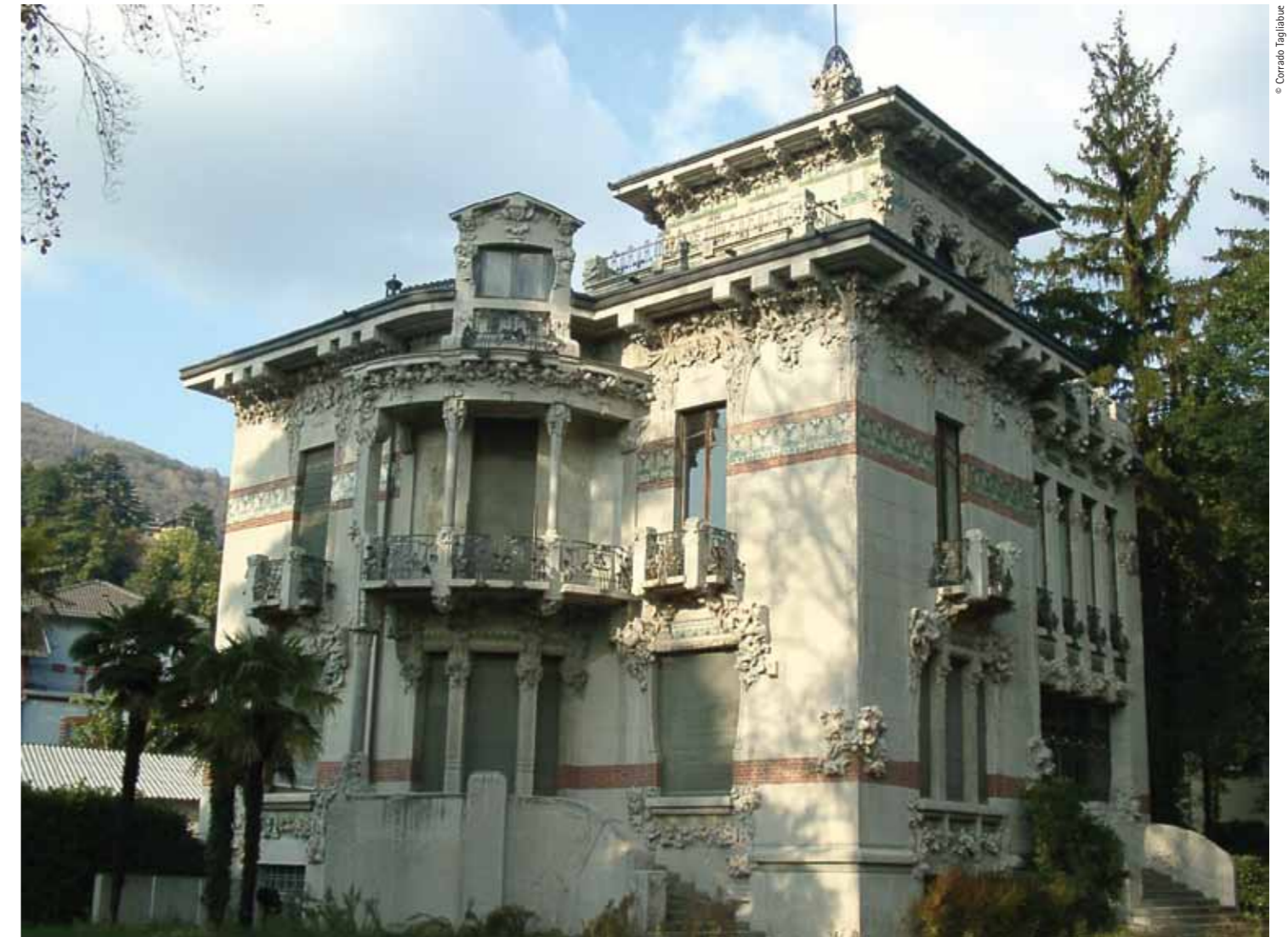
General view of Villa Bernasconi / Vista general de la Vil·la Bernasconi
