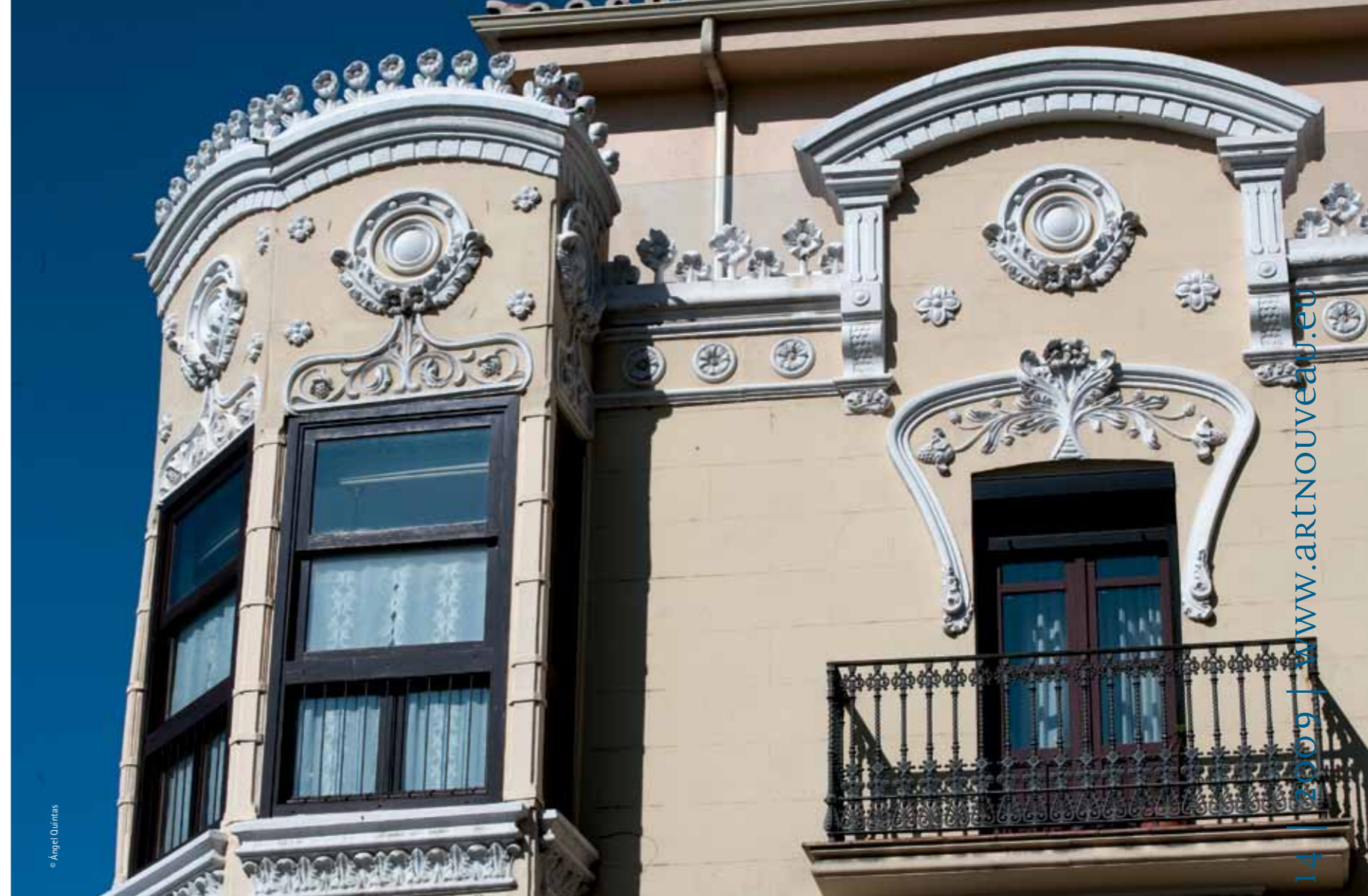
Partial view of the building by Francesc Ferriol (1913) on Carretera de Sanabria / Vista parcial de l'edifici de Francesc Ferriol (1913) a la carretera de Sanabria
