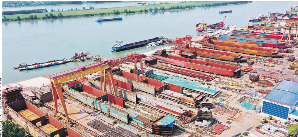
27 июля 2022 года. В судостроительном промышленном парке Ичан в городе Жицзян (провинция Хубэй) идёт строительство судов грузоподъёмностью 10 000 т
