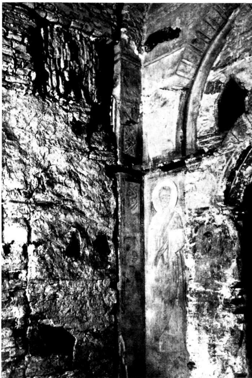
Рис. 5. Крещальня. Фрагмент зенита аркбутана и позднейший столб-прикладка.
