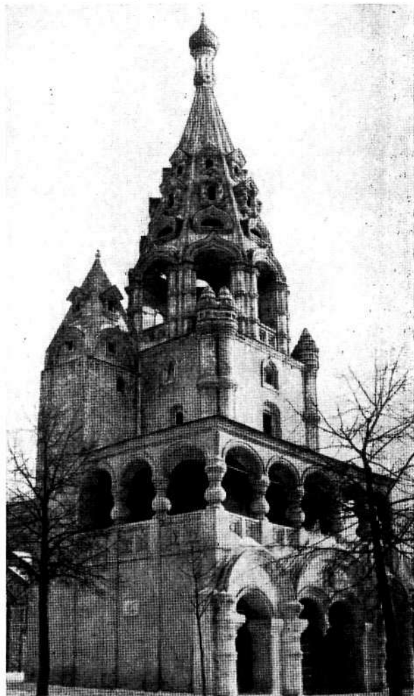
Рис. 3. Надвратный комплекс с церковью Гурия, Самона и Авива, колокольней и башней для часов при церкви Рождества Христова. После проведения реставрационных работ. Фот. А. Н. Кувыркина.
