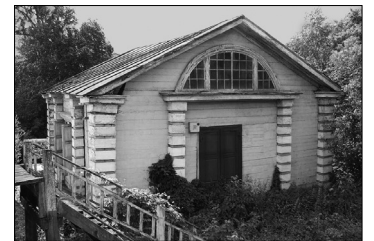
Шосткинський казенний пороховий завод. Будівля вододіючої порохової фабрики. 18 ст. Фото 2010.
