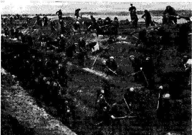
Жители Подмосковья на строительстве оборонительных сооружений. Осень 1941.
