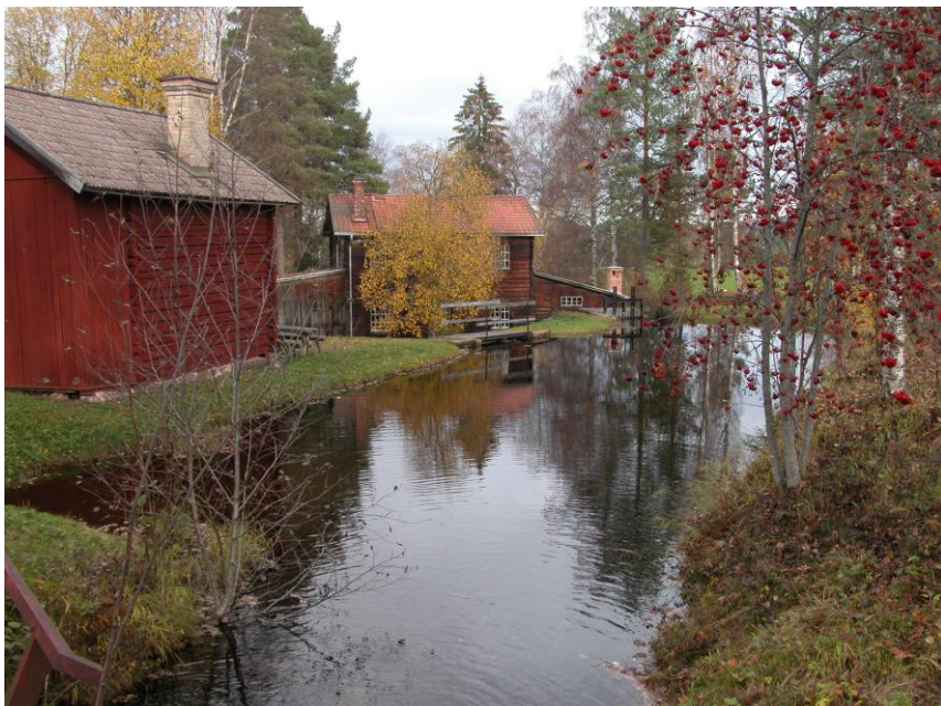
Плотины на прудах. Эльфдаленская мануфактура. 2006 г. (А.Б.)
