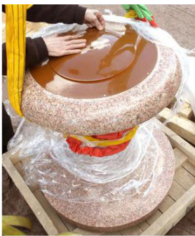
Изготовлена крышка новой конструкции На ней будет укреплен венчик для отпугивания голубей (А.А.).
