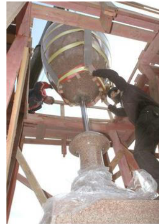
Установка вазы на пьедестал. Май 2012 г. (А.А.)
