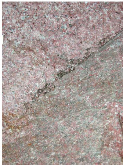
Трещина с биопоражениями и свежий гранит (А.Б.)
