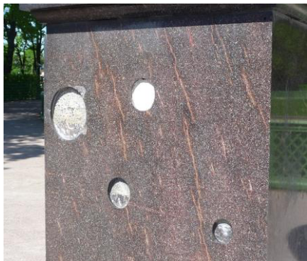
Старые заплатки изъяты. Новые вставки будут сделаны из оригинального блюбергского порфира. 23 мая 2012 г. (А.Б.)
