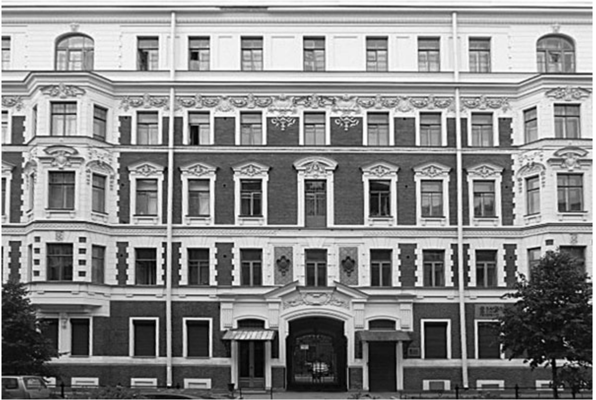
Жилой дом № 20 на 3-й линии Васильевского острова
