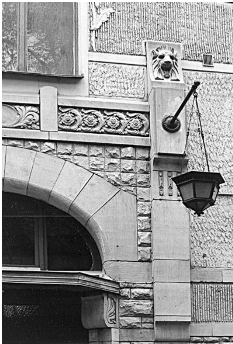
Резьба по горшечному камню и фактурная штукатурка. Каменноостровский пр., 3
