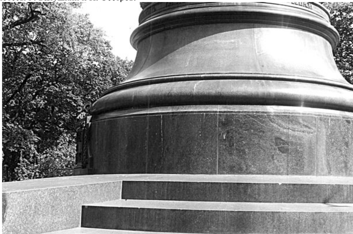
Постамент памятника Екатерине II собран из монолитов розового (внизу) и серого (вверху) гранита
