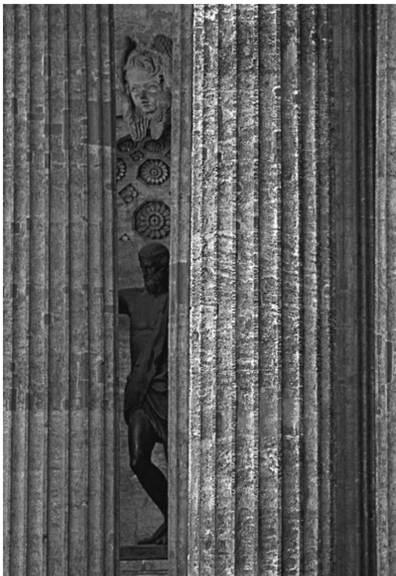
Несчастливые колонны Казанского собора. Их материал – пористый и непрочный известковый туф
