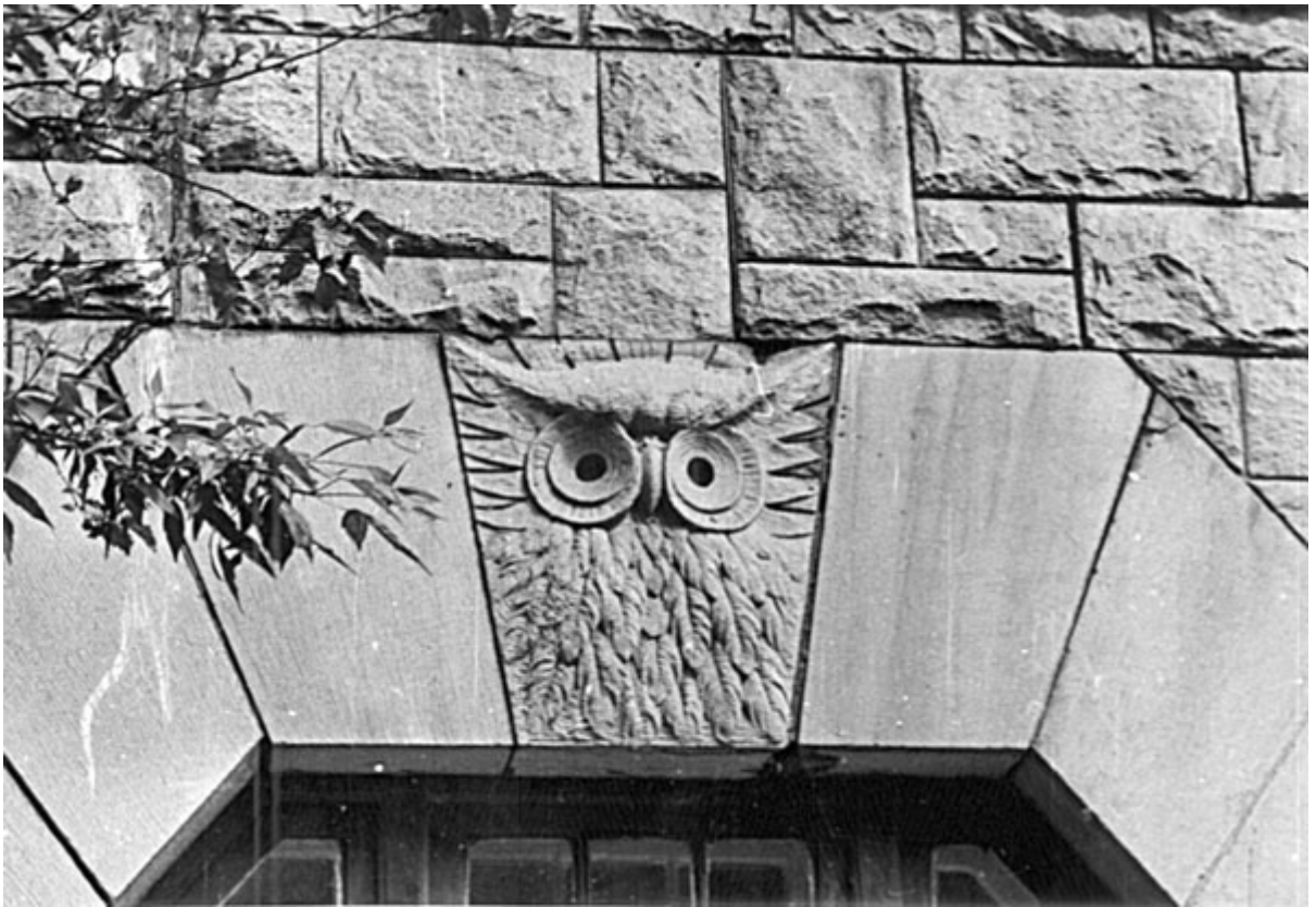
Горшечный камень в резных деталях и блоках. Ул. Ленина, 33
