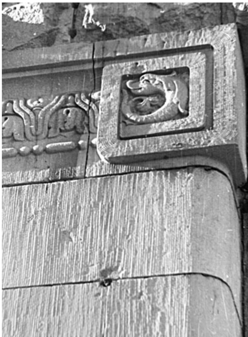
Все детали фасада – горшечный камень. Б. Конюшенная ул., 19
