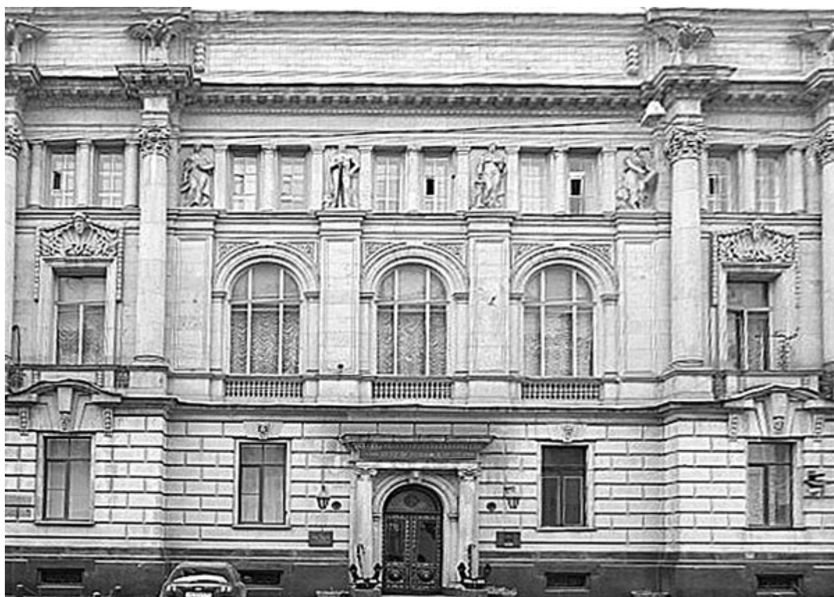
Фасад Николаевской морской академии. Цоколь отделан гранитом, стены на всю высоту – горшечным камнем
