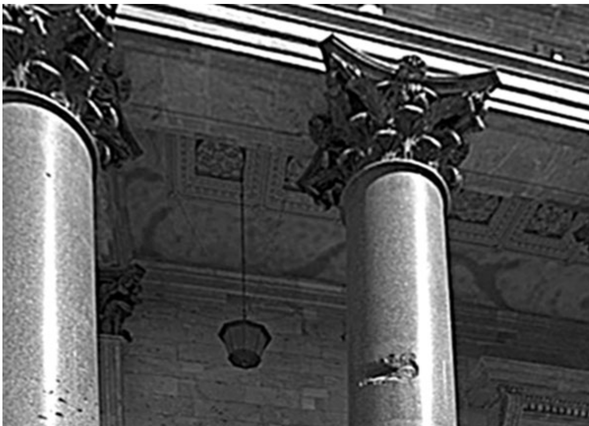
Следы снарядов на гранитной колонне
