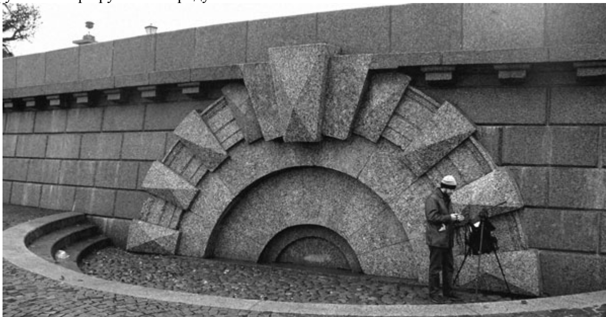
Стенка спуска к Неве на стрелке Васильевского острова отделана серым и розовым финским гранитом рапакиви
