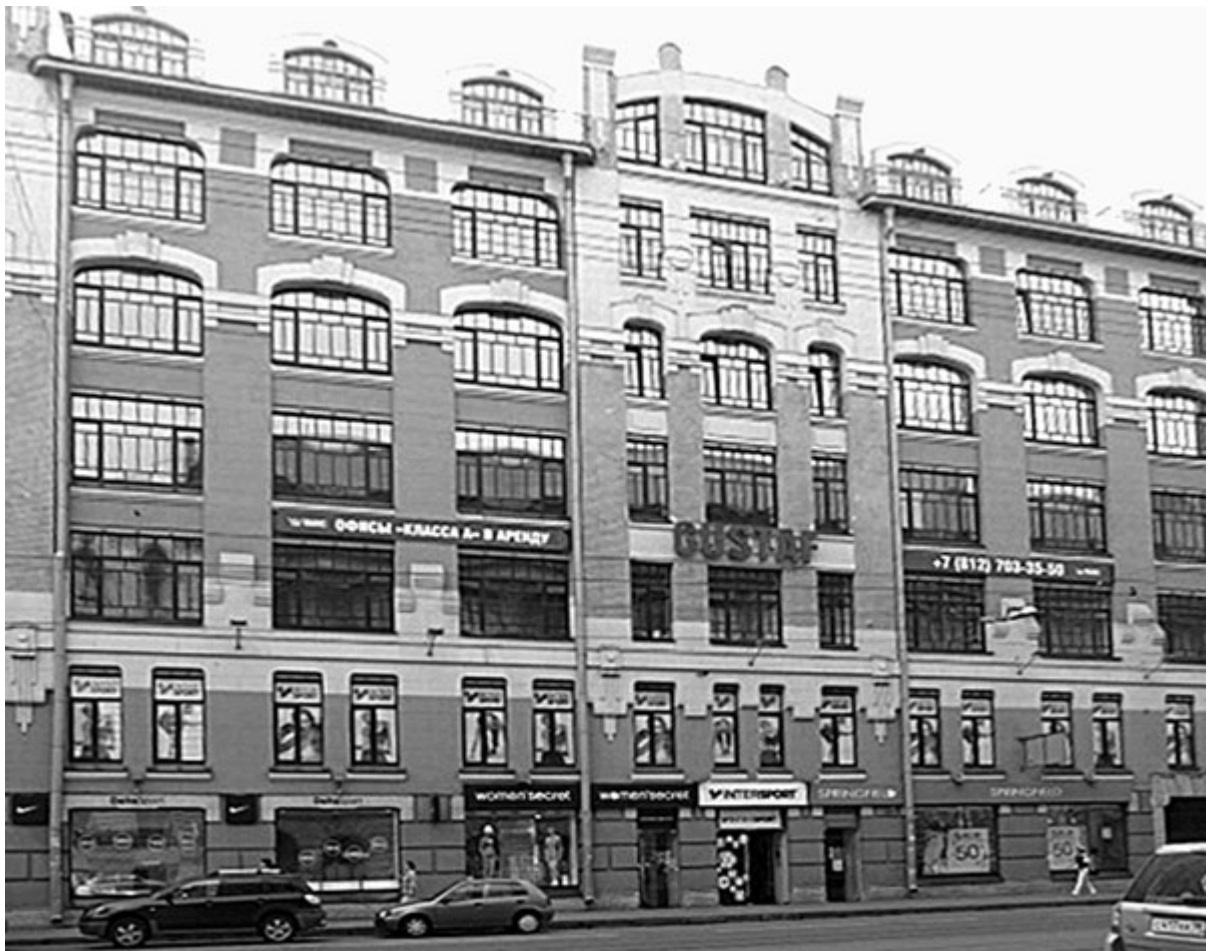
Здание бывшей табачной фабрики Лаферм (позже – Урицкого) теперь занято разными магазинами и офисами
