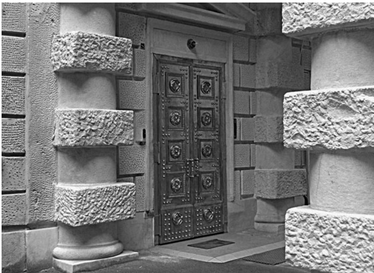
Стены двух нижних этажей дома эмира Бухарского облицованы мрамором с Урала, из него же иссечены причудливые по форме колонны
