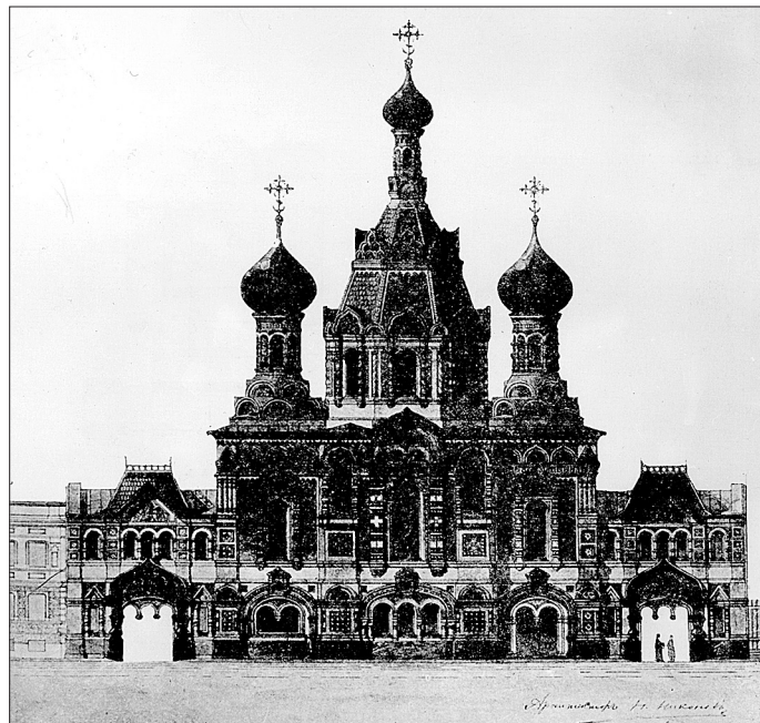
Боковой фасад церкви подворья Задне-Никифоровой пустыни. 1894-1900 гг.
