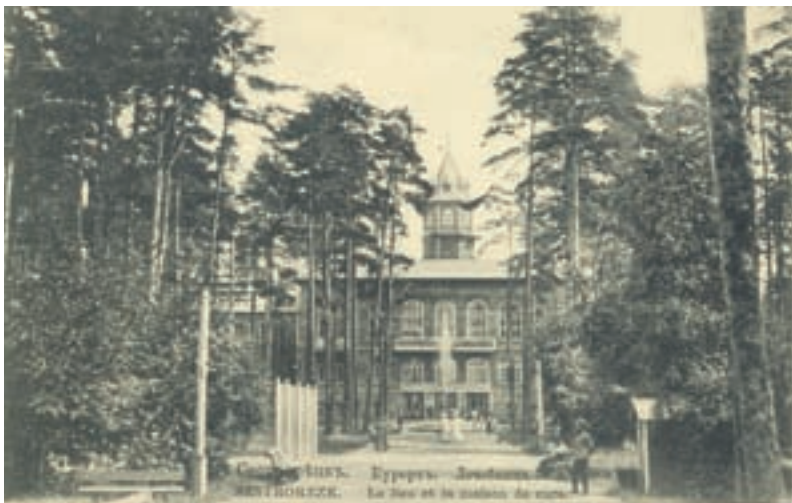
Главный лечебный корпус
