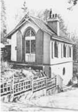
La « Chapelle de la Grosse Grange » de Mézery (1813-1816), loge du portier à l'entrée de la campagne de César-François de Constant (1777-1868), « petit bâtiment de fantaisie simulant une chapelle gothique ».
