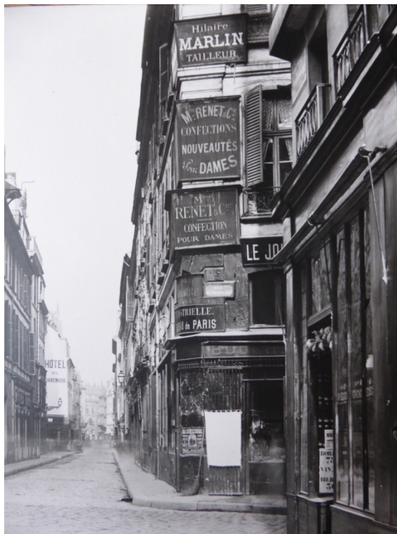
Fig.22 : Charles Marville : Carrefour Richelieu-Saint-Augustin depuis la rue des Filles-Saint-Thomas au milieu du XIXe siècle. Détail sur le petit hôtel Boutin (BHVP, GP VI 13, droits réservés).
