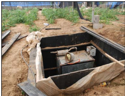
Генератор и землеройное оборудование возле входа в туннель. Генератор был прикрыт слоем земли для обеспечения звукоизоляции и трудности его обнаружения (Сайт пресс-атташе АОИ, 16 августа).
