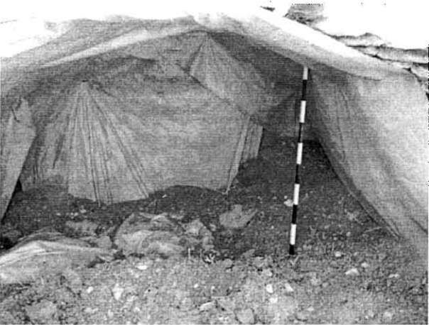
Рис. 5. Начало консервации склепа Св. Василия: свод склепа укрыт специальным геотекстилем
