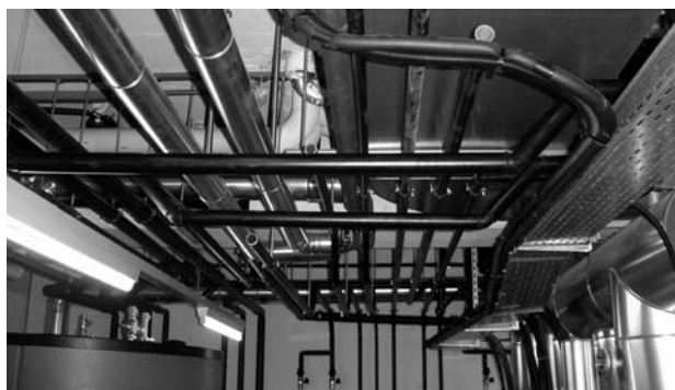
Spital Herisau, Erneuerung Warmwasser-Leitungen
