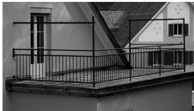
PZA, Haus I, saniertes Flachdach
