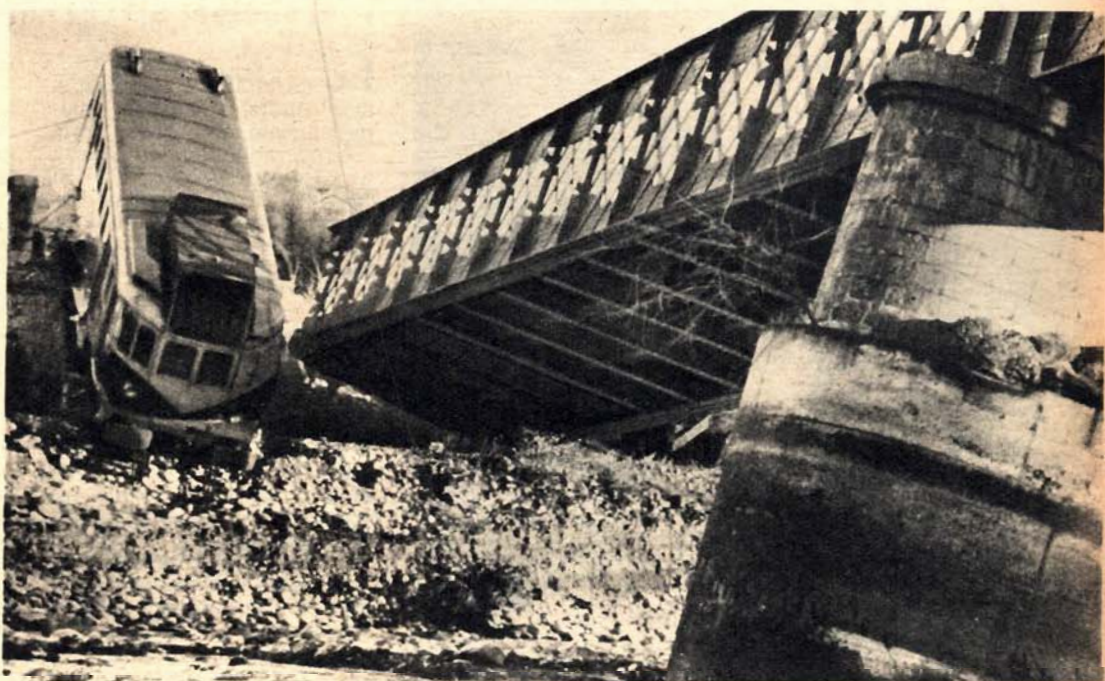
La piena del torrente Dranse ha fatto crollare il pilone centrale del ponte lungo la strada Evian-Lione. Un autopullman che stava per attraversarlo si è trovato improvvisamente dinanzi al vuoto: la pronta frenata del conducente ha però trattenuto il grosso veicolo sulla scarpata, evitando la catastrofe.
