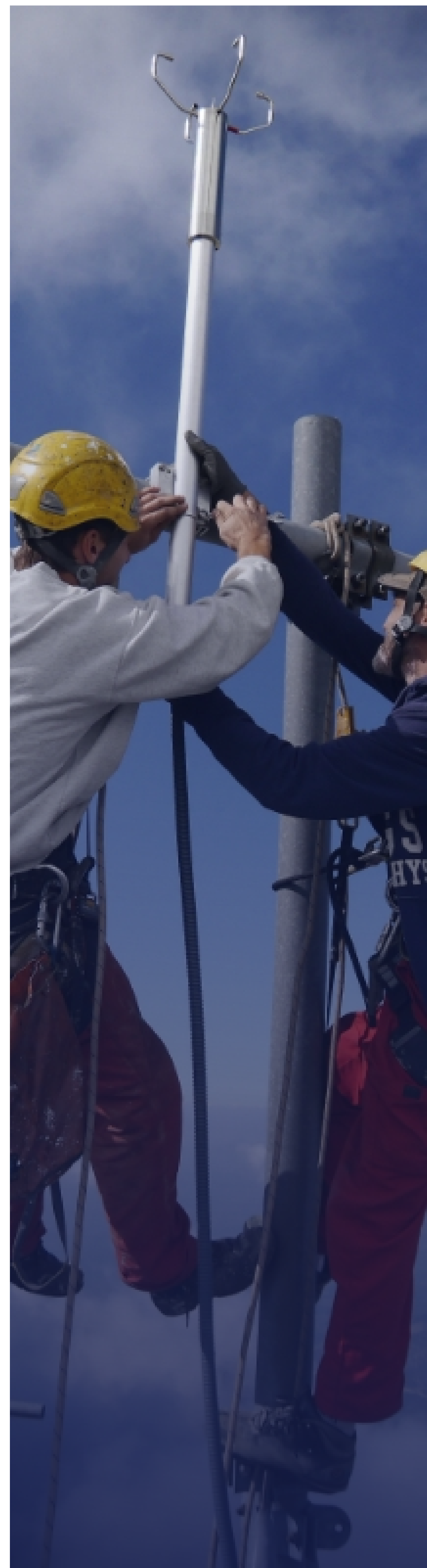
Installation d'une station météorologique au sommet du Mont-Ventoux
