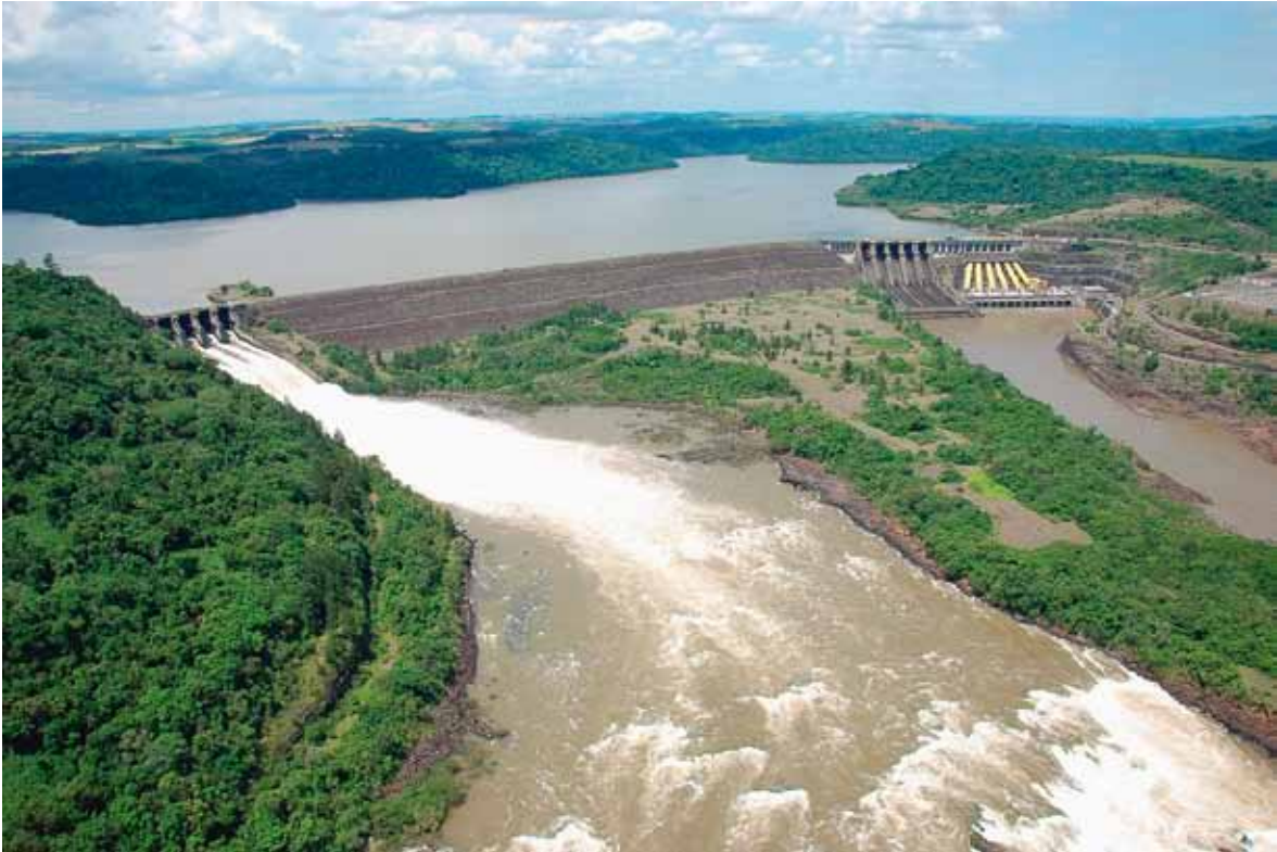
Usina Hidrelétrica de Salto Osório (foto cedida por Marcos Aurélio Zanella).
