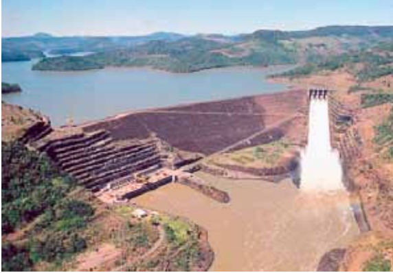
Usina Hidrelétrica de Foz do Areia (foto cedida pela Copel).
