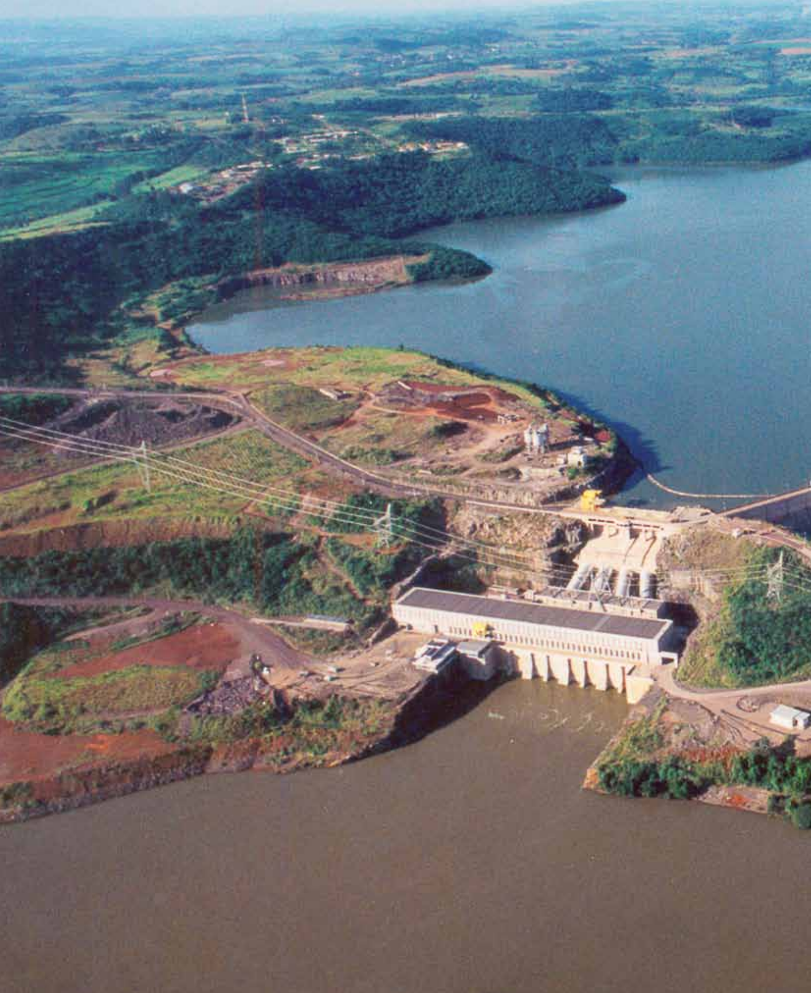
Usina Hidrelétrica de Salto Caxias (foto cedida pela Copel).
