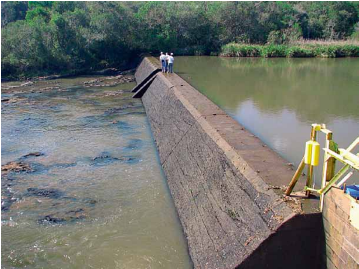
Usina Hidrelétrica de Salto do Vau (foto cedida pela Copel).
