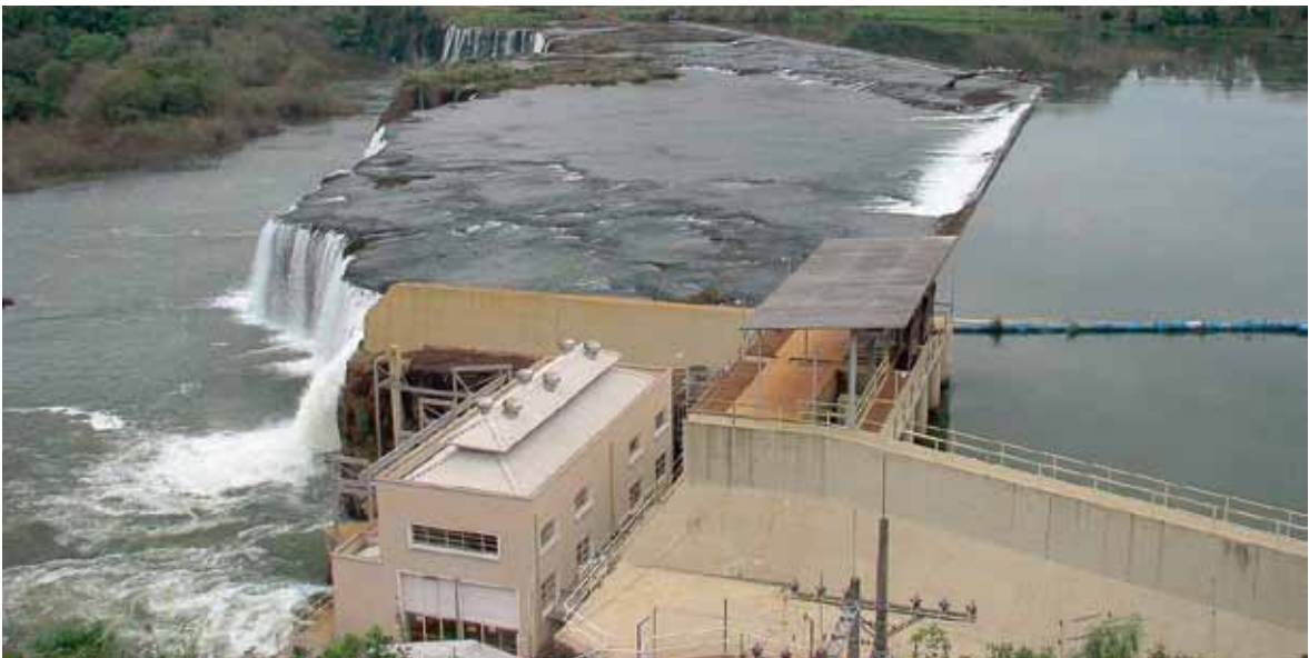
Usina Hidrelétrica Foz do Chopim (foto cedida pela Copel).
