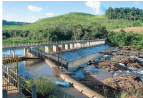
Usina Hidrelétrica do Cavernoso (foto cedida pela Copel).
