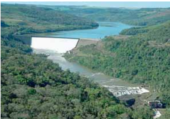
Usina Hidrelétrica de Foz do Jordão (foto cedida pela Copel).
