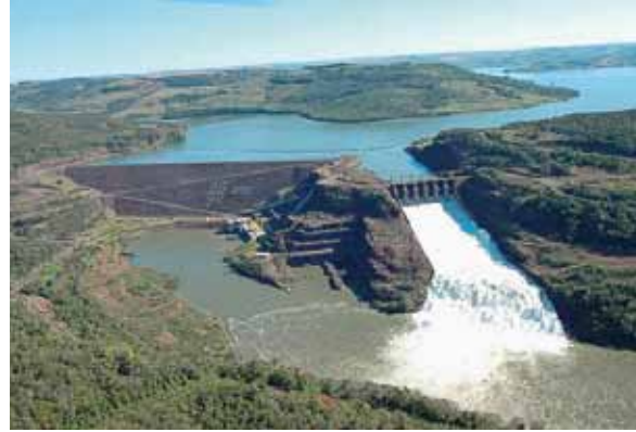
Usina Hidrelétrica de Segredo (foto cedida pela Copel).
