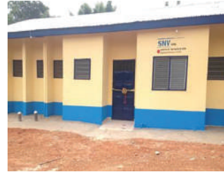
JSDF の後： タマレ教員養成校の トイレ設備
