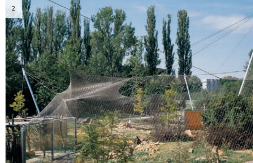
2 Löwengehege mit von außen spannenden Pylonen Lions enclosure with pylons tensioning from the outside
