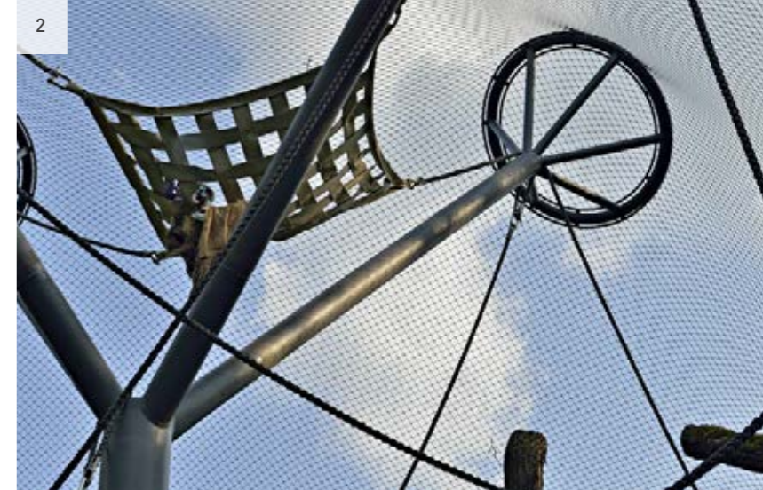
2 Pylon-Verzweigung für Gehege-Gestaltung und Last-Verteilung Pylon with branches for enclosure design and for load distribution
