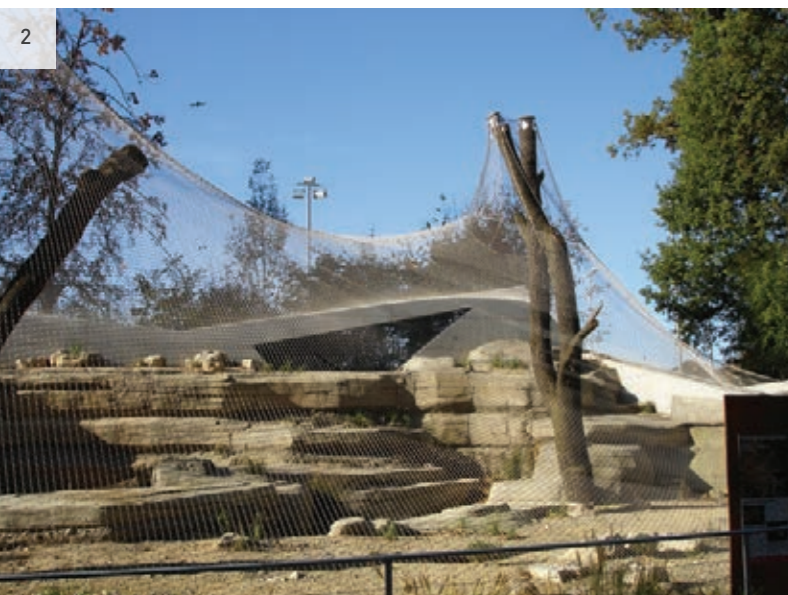
Pylone als Bäume gestaltet Pylons in a tree-like look
