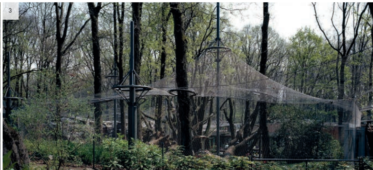
Gehegebau in bestehendem Waldbestand, Baumdurchdringungen im Dachnetz integriert
