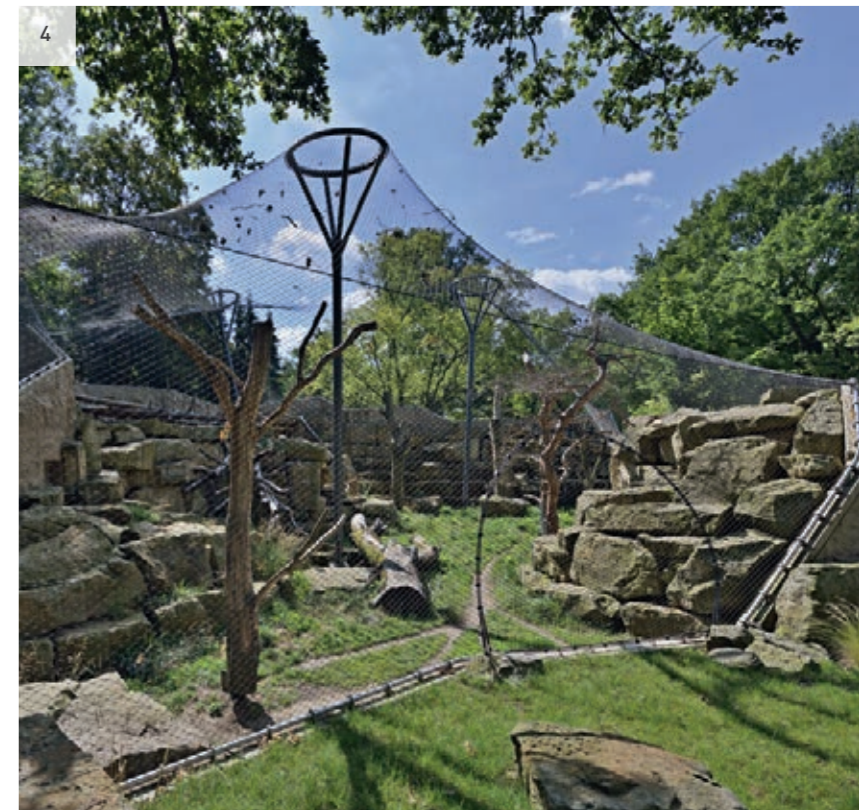
4 Revisionsöffnung im Wandnetz für Gehegepflege Inspection entrance in the wall mesh for the enclosure's maintenance
