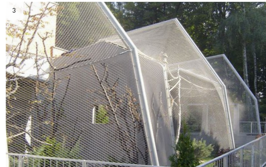
3 Außengehege mit Separierung, mit fließender Netzüberdeckung Exterior enclosure with separate units, and with continuous mesh cover
