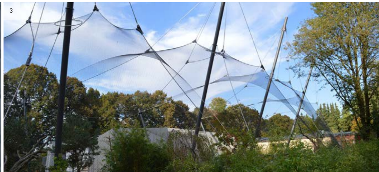
Begehbare Voliere für Watvögel mit außenliegender Zugseil-Konstruktion
