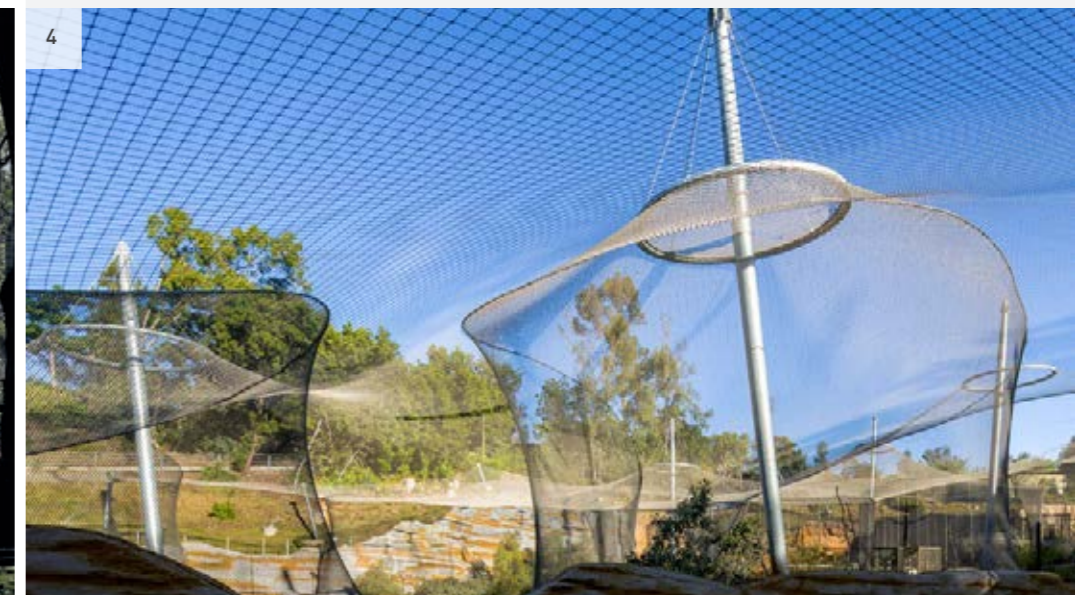
Wandnetze mit optimiertem, und somit optisch reduziertem Dachnetzanschluss Wall mesh with optimized and thus almost imperceptible attachment to the roof mesh
