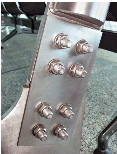
Edelstahl-Teile erfordern Edelstahl-Befestigungsmittel.
