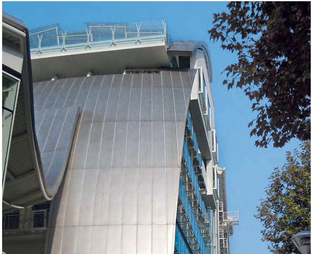
Teile der Gebäudehülle, die der Witterung ausgesetzt sind, werden durch Regenwasser wirksam gereinigt. Foto: Centro Inox, Mailand (I)
