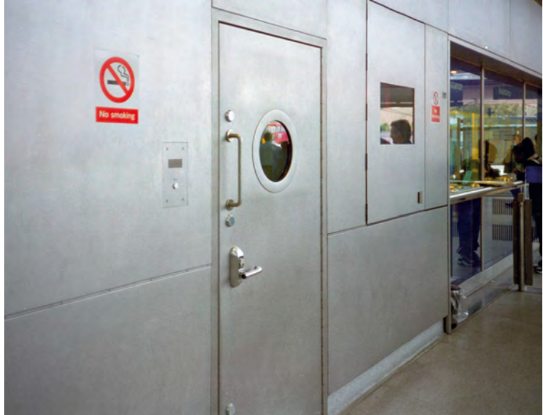
Kugelgestrahlte Oberflächen erweisen sich im Schalterbereich des Bahnhofes im britischen Southwark als robust.
