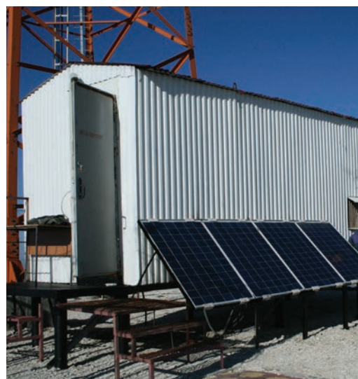
Солнечные электрогенераторы на ПРС «Кырк» – реализация одной из разработок Е.Г. Пашука
