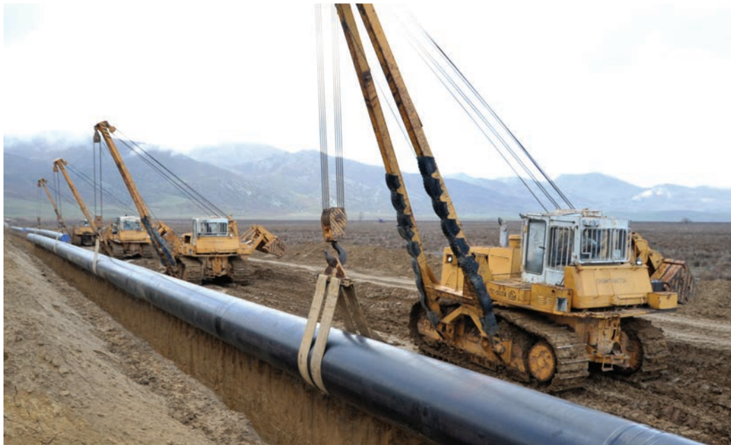
Слаженная работа трубоукладчиков – точный расчет
