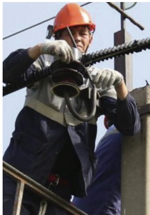
Монтаж птицевозащитного устройства
