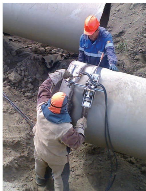
Подготовка стыка трубы
