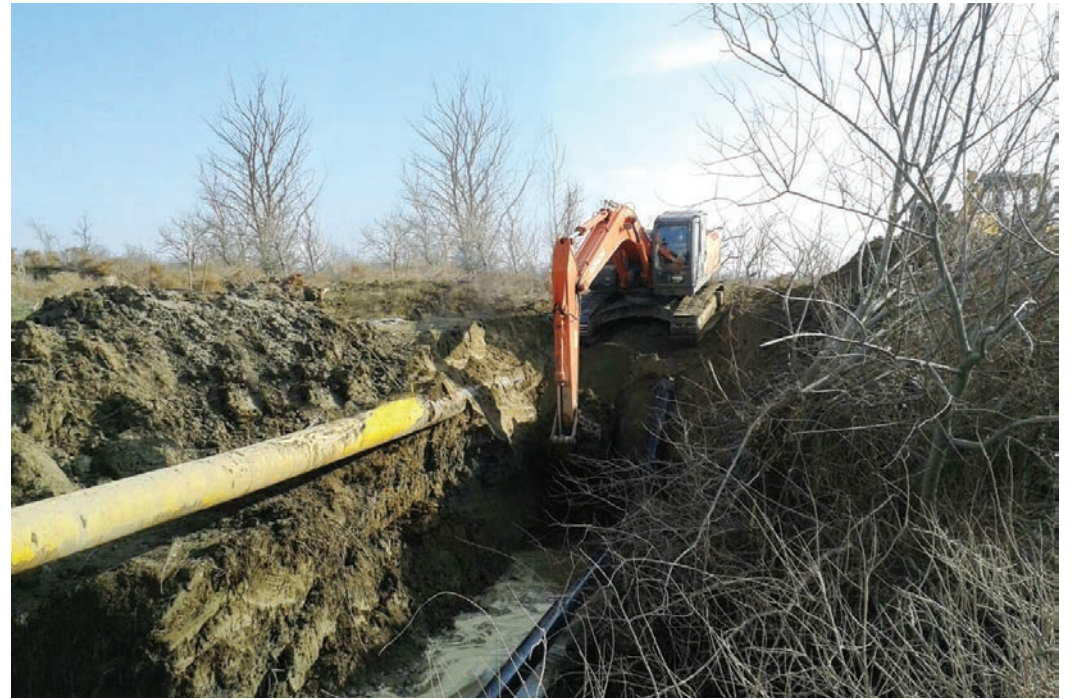
Работа по заглублению подводного перехода через канал
