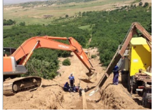
Замена поврежденного участка трубы
