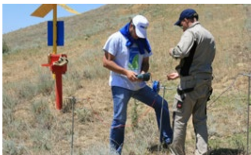
Измерение потенциала грунтов в зоне магистрального газопровода
