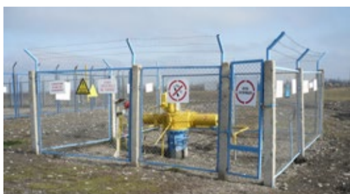
Запорная арматура Ду 1000 мм
