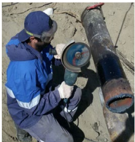
Замена дефектного участка трубопровода
