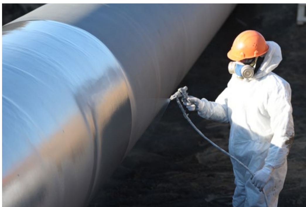
Нанесение изоляционного покрытия
