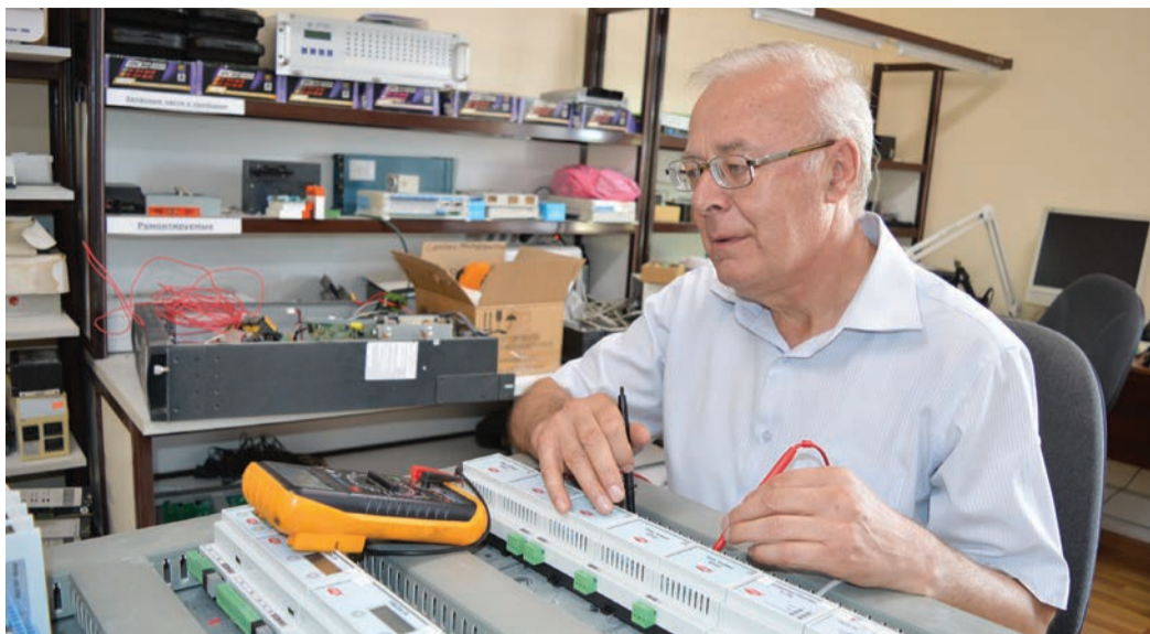
Проверка монтажа САУ ГРС
