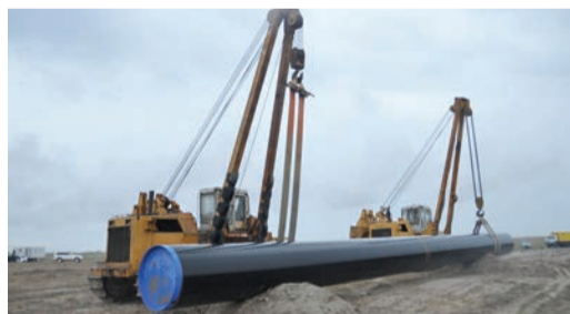
Монтажная заготовка, готовая к врезке
