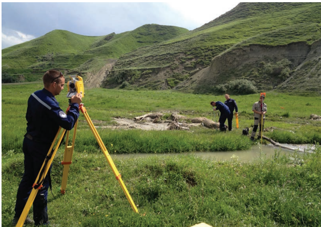
Измерение глубины залегания перехода газопровода-отвода «Акуша» через реку Мугинка
