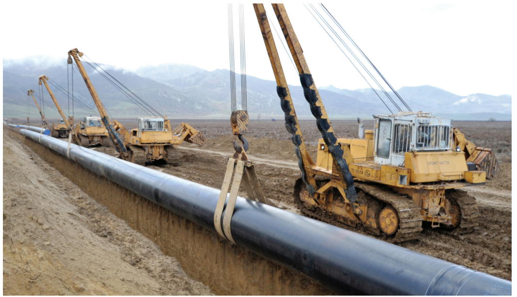
Укладка сваренной трубной плиты в траншею
