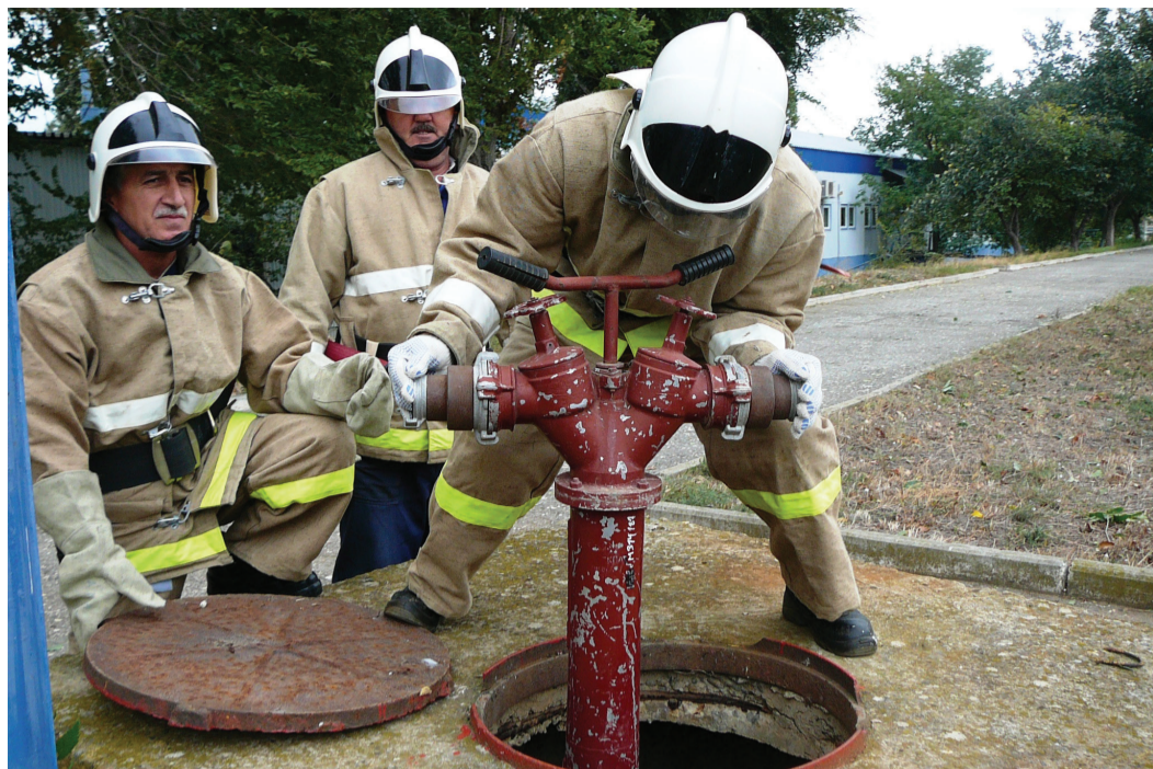
Установка пожарной колонки на гидрант
