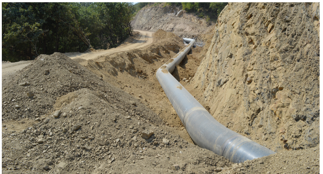
Уложенный в траншею участок газопровода
