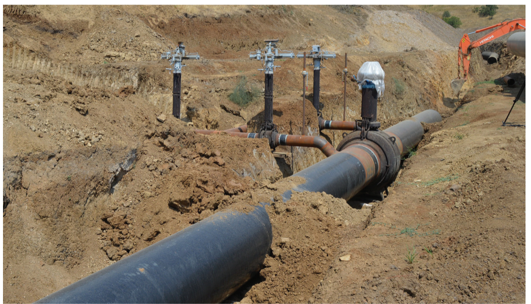
Строительство кранового узла
