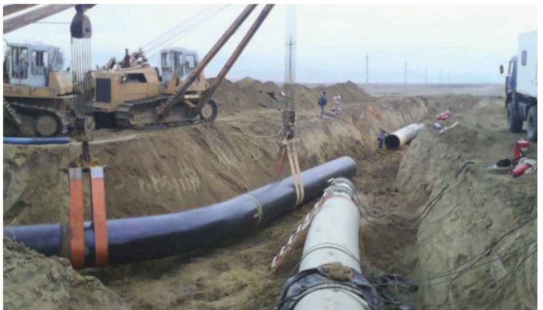
Монтажные работы при подключении участка после реконструкции к действующему газопроводу
