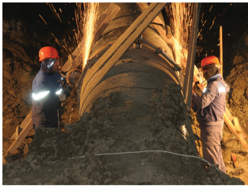
Зачистка первого слоя сварочного шва от шлака и пор
