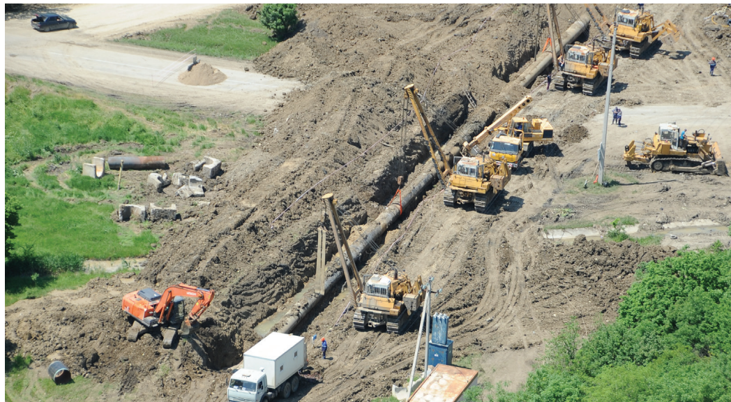
Основные работы на участке 690–718 км МГ «Моздок – Казимагомед» по подключению перехода через автодорогу «Сивух – Аксай»
