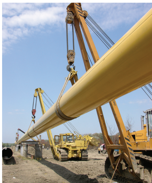
Август 2004 года. Монтаж воздушного перехода через р. Терек
