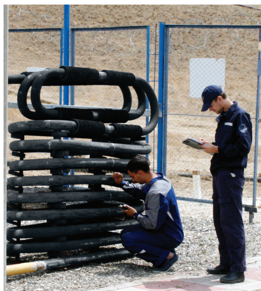
Ультразвуковой контроль сварных соединений на подогревателе газа ГРС
