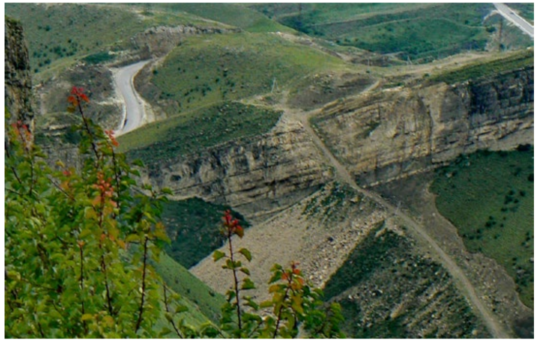
Вид на участок ГО «Ботлих», построенный через вертикальный скальный склон высотой 58 м
