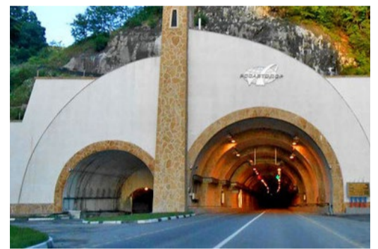
Въезд в Гимринский автодорожный тоннель
