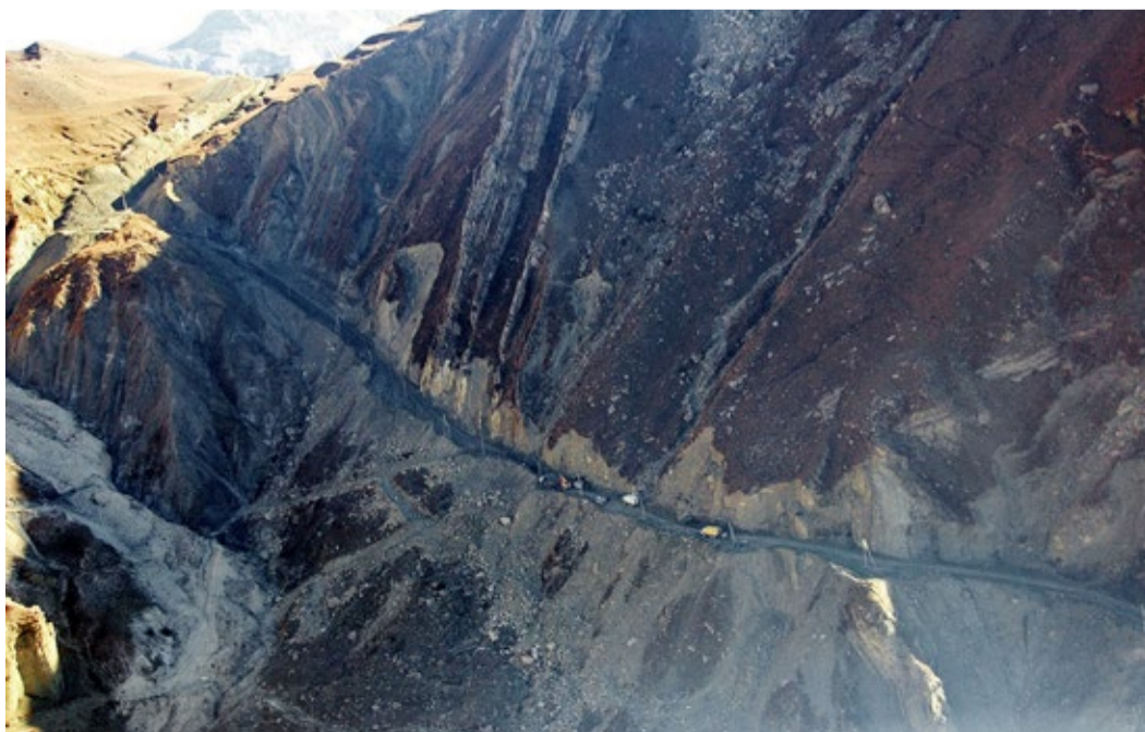
Трасса ГО «Ботлих», проходящая по крутому осыпному склону
