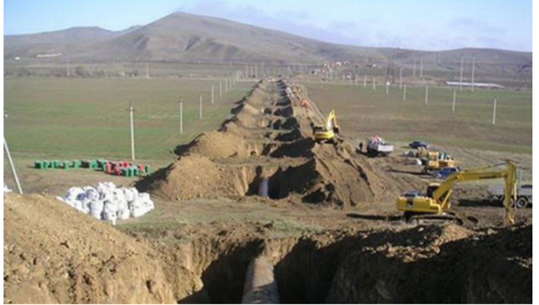
Переизоляция на участке 811,9–832 км МГ «Макаг – Северный Кавказ»
