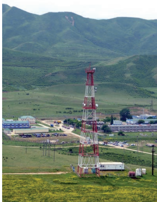
Вид на ПРС и административно-производственный комплекс Кизилюртовского ЛПУМГ
