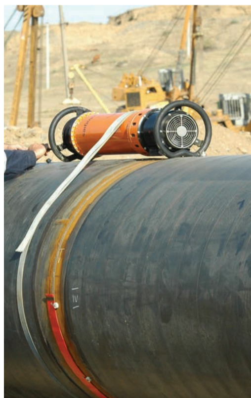
Подготовка к рентгеновскому контролю сварного соединения газопровода в полевых условиях
