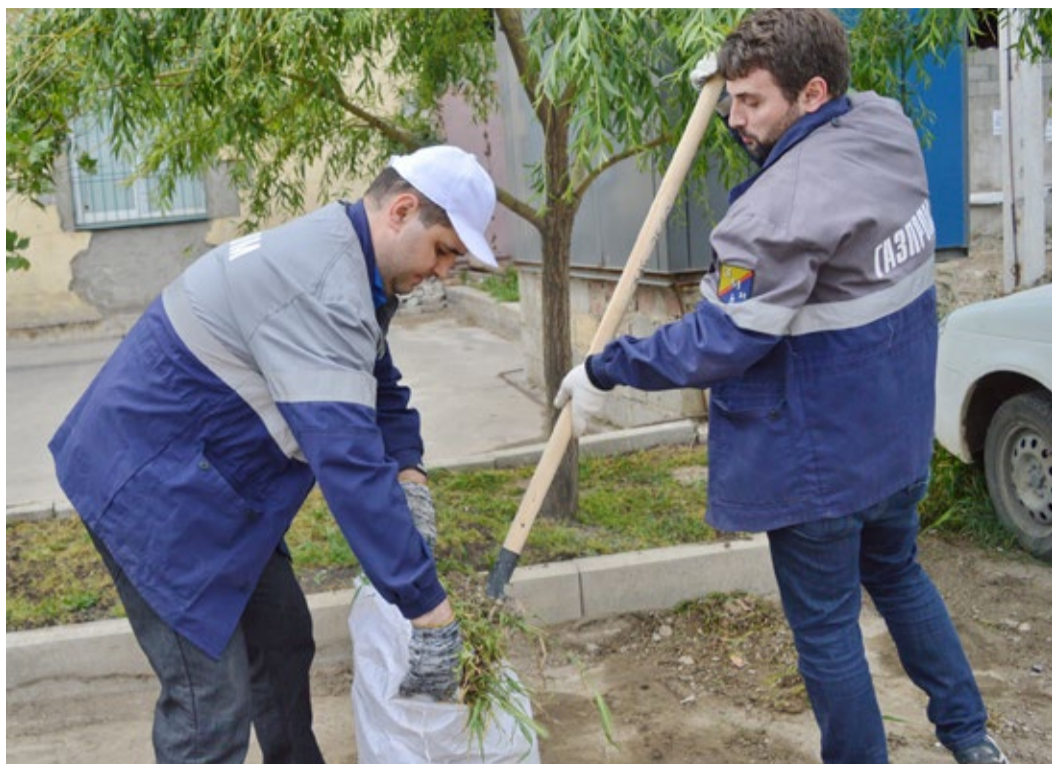
Очистка дороги от наносного мусора
