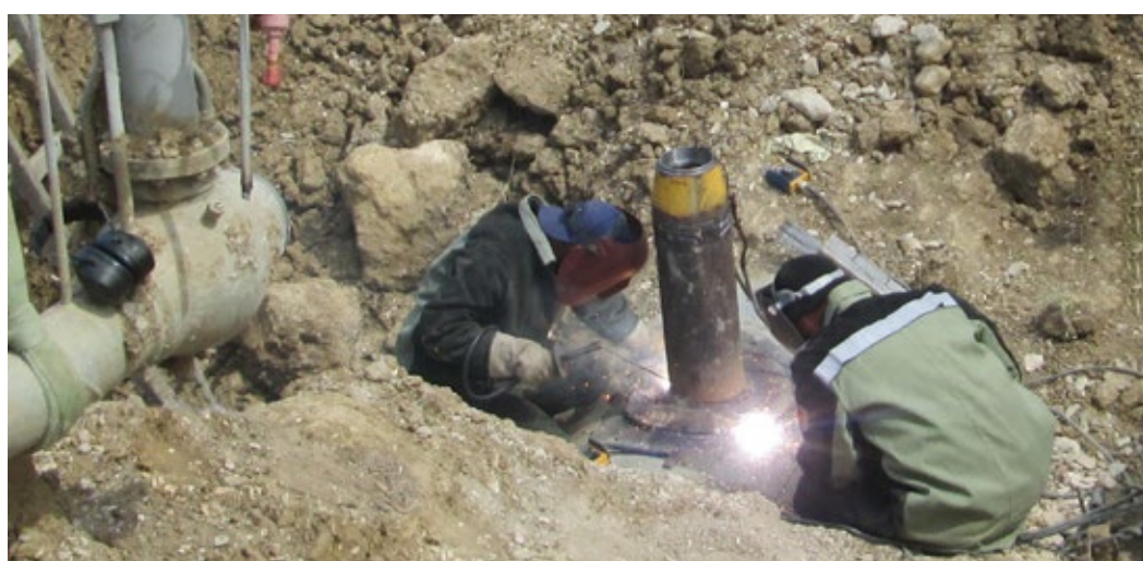
Монтаж трубопроводной обвязки кранового узла на 585 км МГ «Моздок – Казимагомед»
