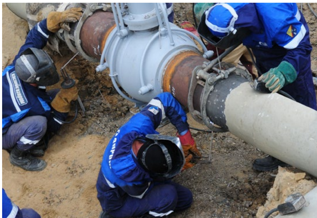
Замена крана DN 300 на байпасной линии кранового узла на 585 км МГ «Моздок – Казимагомед»
