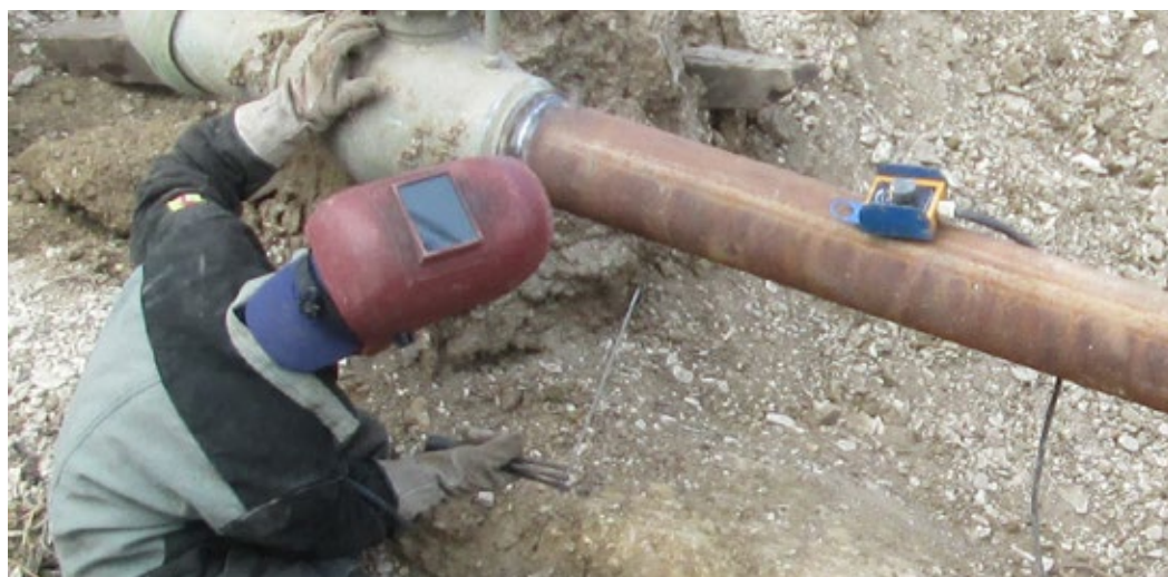
Замена дефектного охранного крана DN 150 на КП 0 км ГО «Охранлар»
