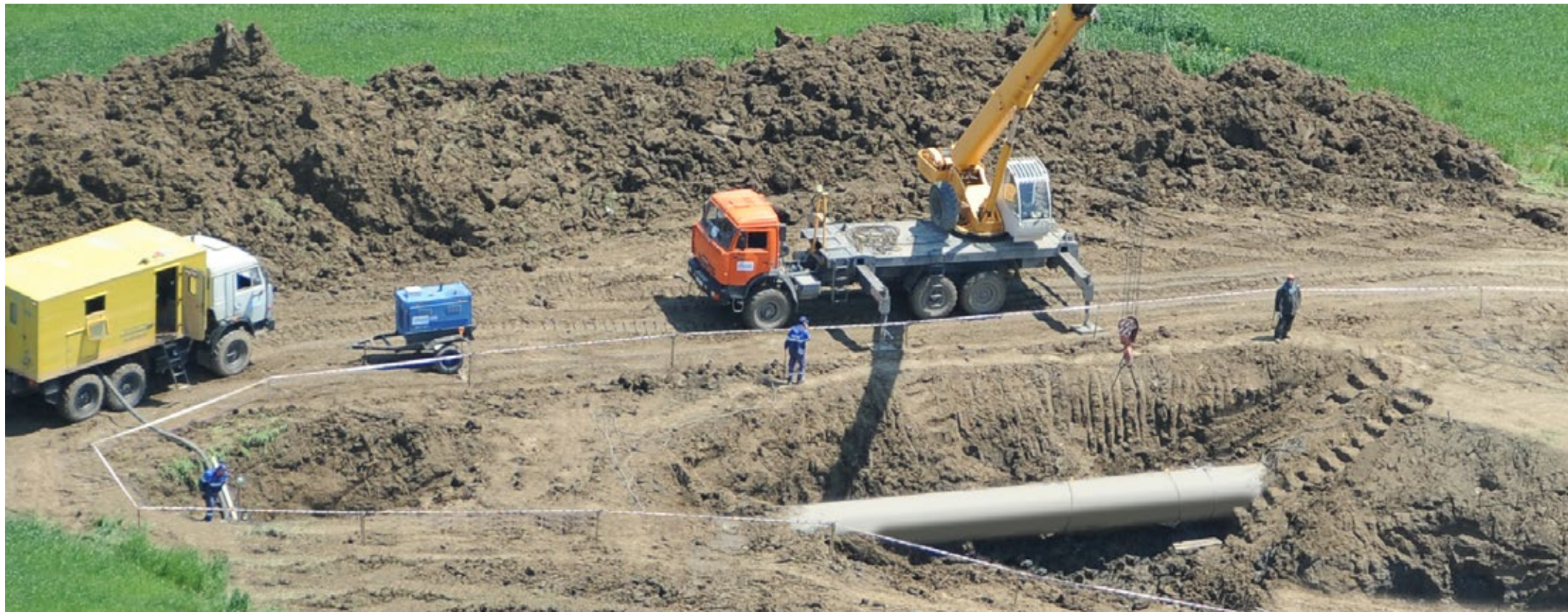
Подготовка поста № 1 на 169 км МГ «Моздок – Казимагомед» к проведению огневых работ
