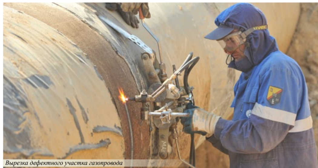
Вырезка дефектного участка газопровода
