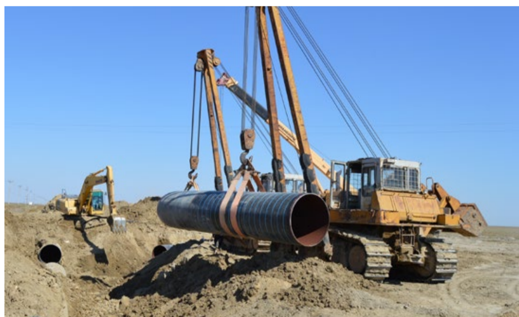
На магистральном газопроводе «Моздок – Казимагомед» проведен капитальный ремонт переходов под автодорогой «Бавтугай – Гельбах» и через канал Чирюртовской ГЭС, общей протяженностью 186 м
