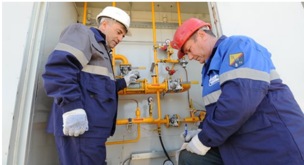
Работники РЭП «Леваши» на проведении планово-профилактических работ на ГРС «Леваши»
