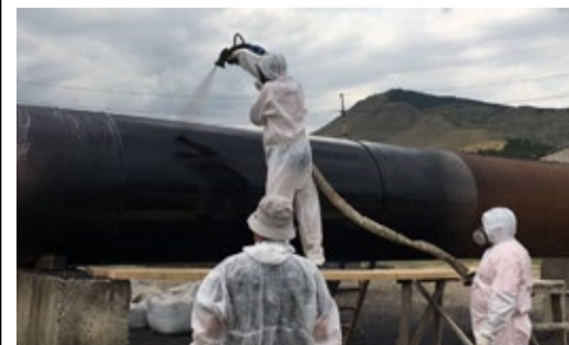
Демонстрация изоляционного покрытия «Карбофлекс»
