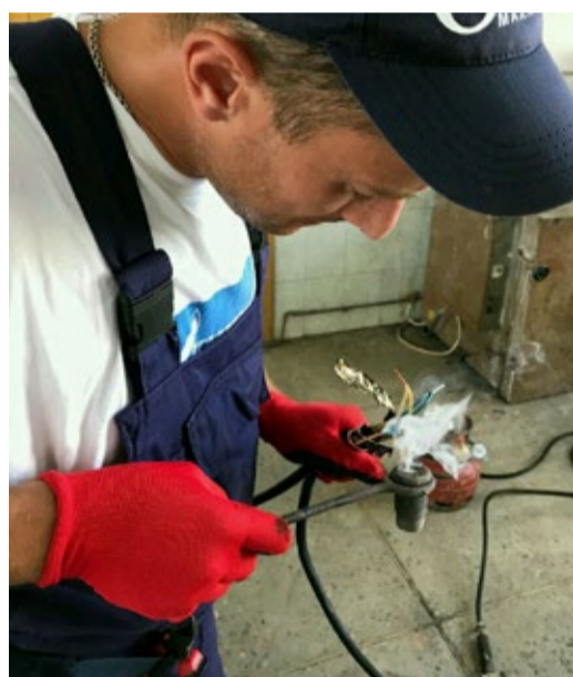
Процесс спайки жил кабеля связи
