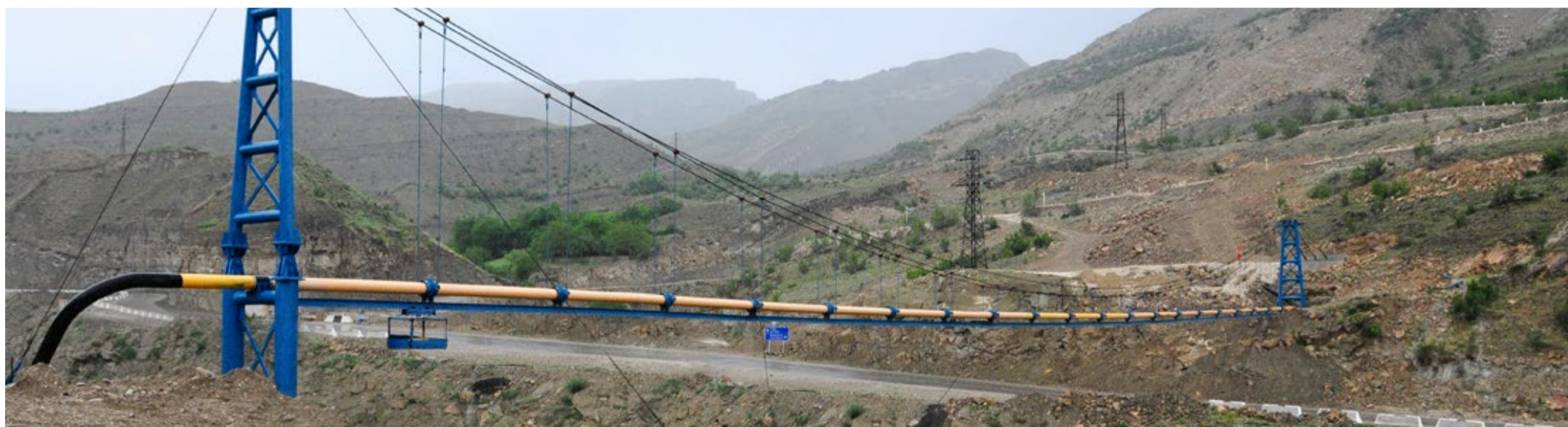
Вантовый переход на газопроводе-отводе к с. Хунзах Хунзахского района РД
