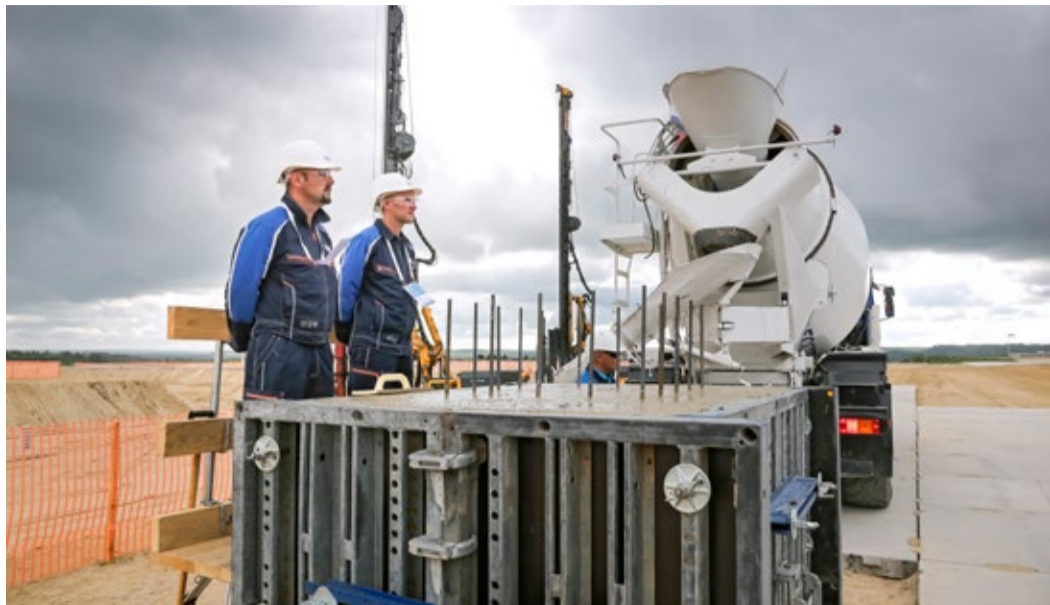
Первый фундамент Амурского ГПЗ
