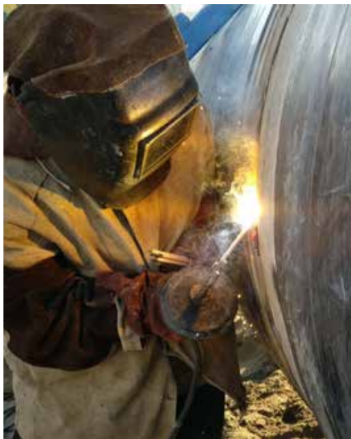
Проведение сварочных работ
