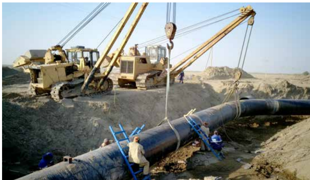
Ремонтные работы на магистральном газопроводе «Мака́т - Северный Кавказ»
