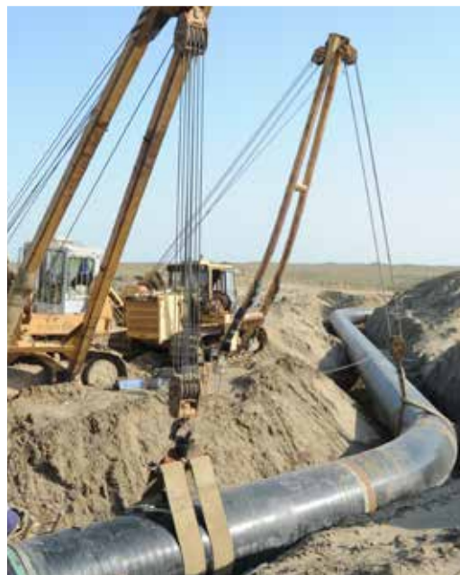
Подключение отремонтированных участков
