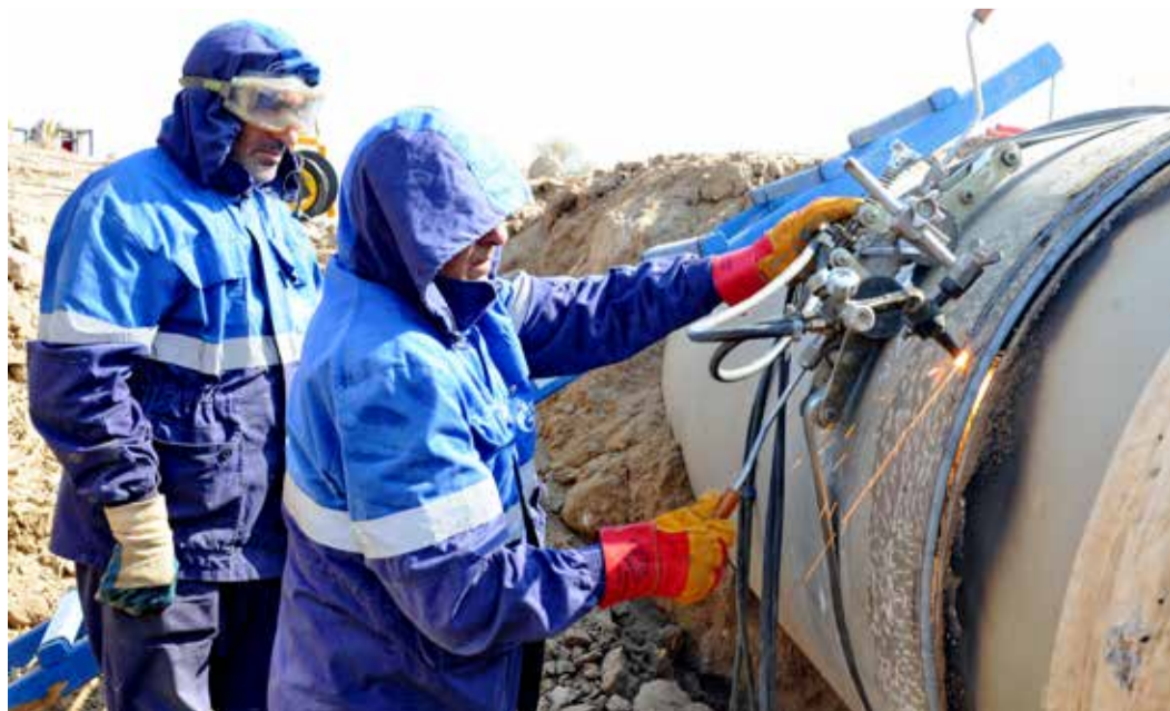
Ремонтные работы на магистральном газопроводе «Моздок - Казимагомед»
