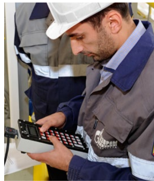
Настройка вычислителя расхода газа Суперфлоу-2Е
