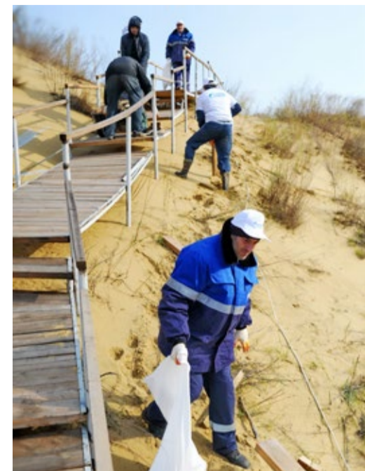
Уборка строительного мусора вдоль экологической тропы
