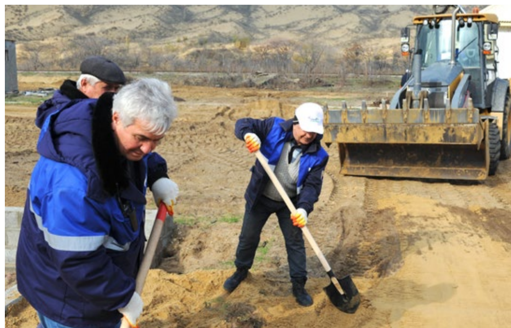
Подсыпка грунта на площадках будущего дендропарка и питомника
